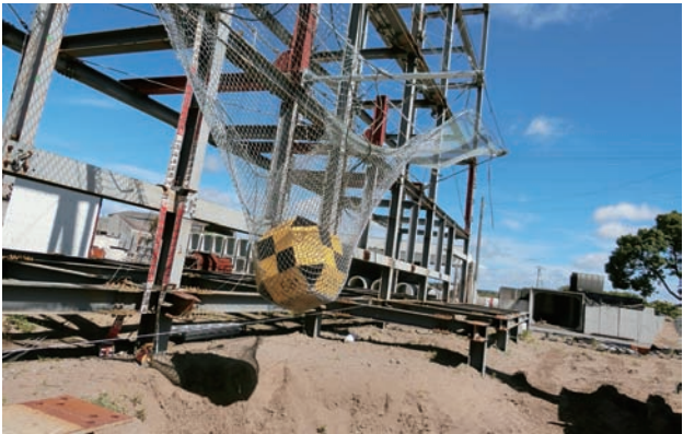
中間スパン捕捉状況
