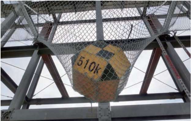
中間スパン捕捉状況
