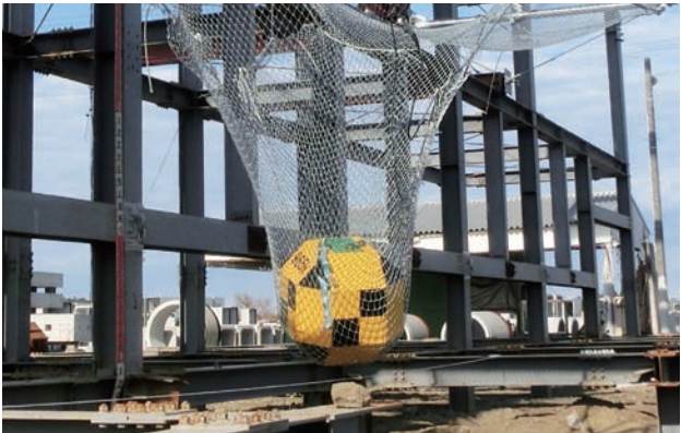
中間スパン捕捉状況
