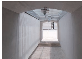
締め上げ完了状態
