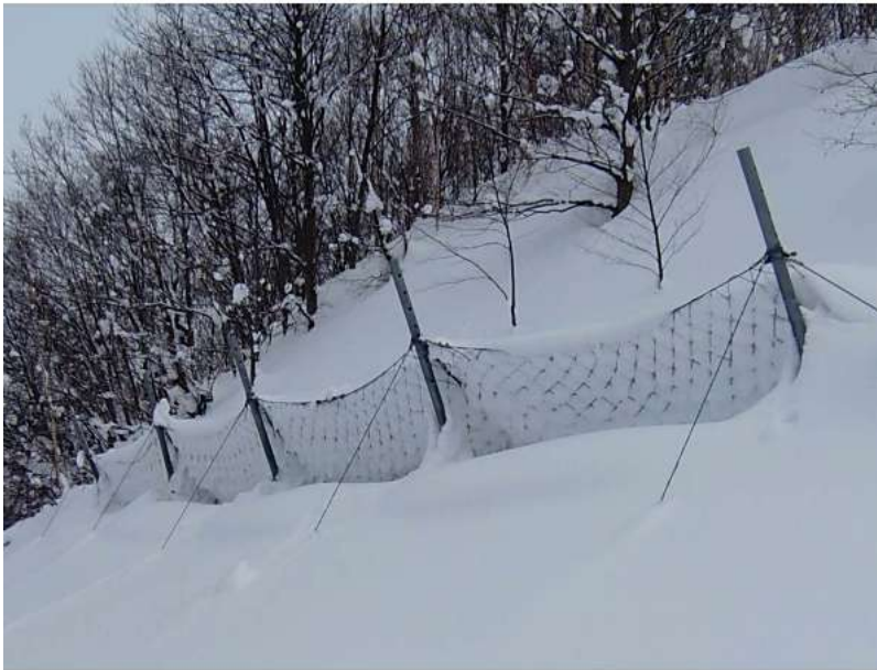
スノーロックフェンス施工例
