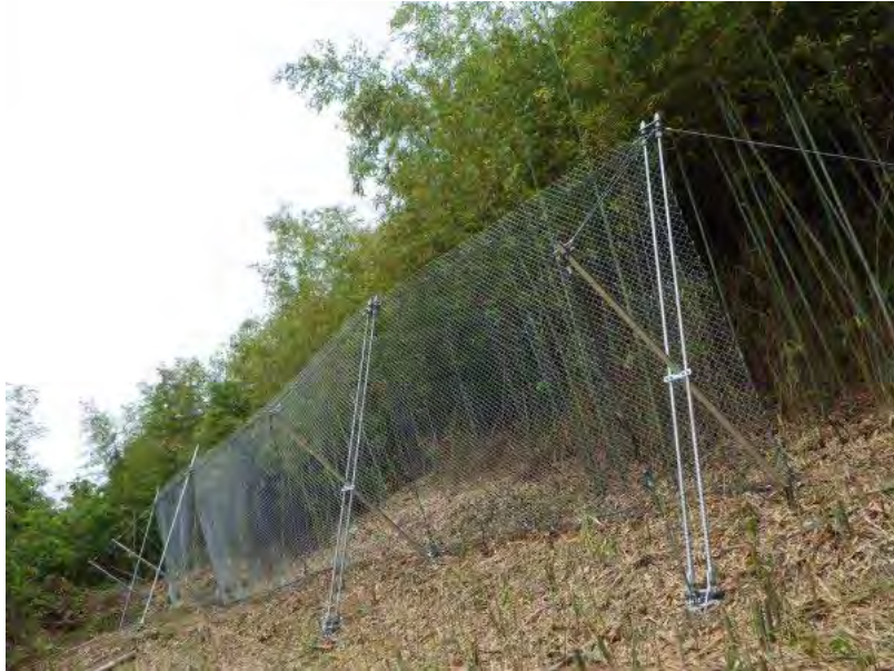
クロスバリア設置状況
