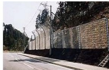
直接基礎(直線支柱+R型支柱)
