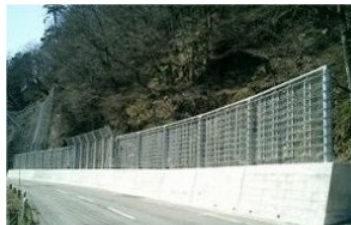
擁壁上(直線支柱+Y型支柱)
