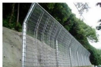
擁壁上(Y型支柱)
