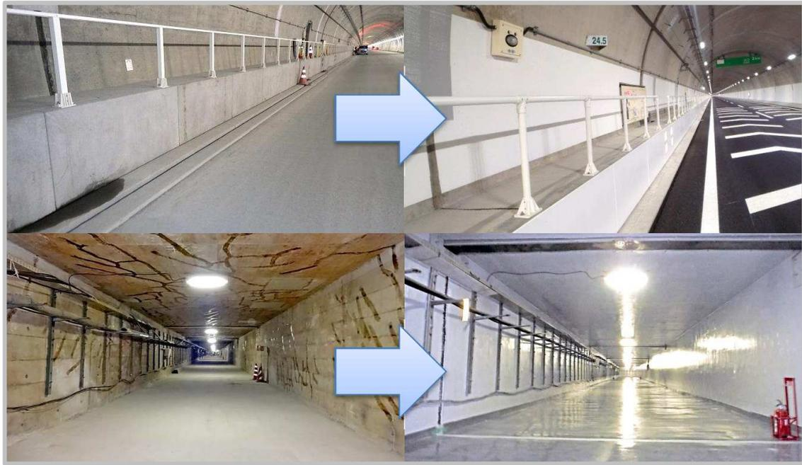
ワンダーコーティングシステムは、常温・塗布で形成されるガラス質膜により構造物を保護する無機系の表面保護工法です。中性化や塩害、凍害等に対する保護性や耐久性、不燃性、防汚性等に優れ、さまざまな用途・構造物・材料に対応が可能です。廃棄後・燃却時に有害物質が発生しない環境に配慮した工法です。
