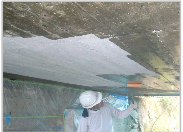
② プライマー塗布工
