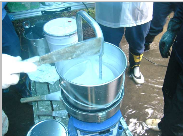
③ 材料攪拌状況
