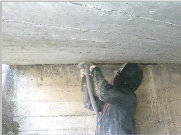
① 下地処理工(ケレン工)
