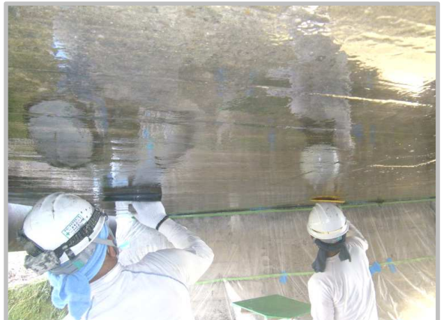
④ 表面被覆工(床版下面)
