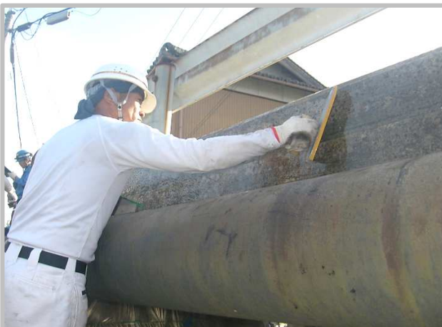
⑤ 表面被覆工(地覆)
