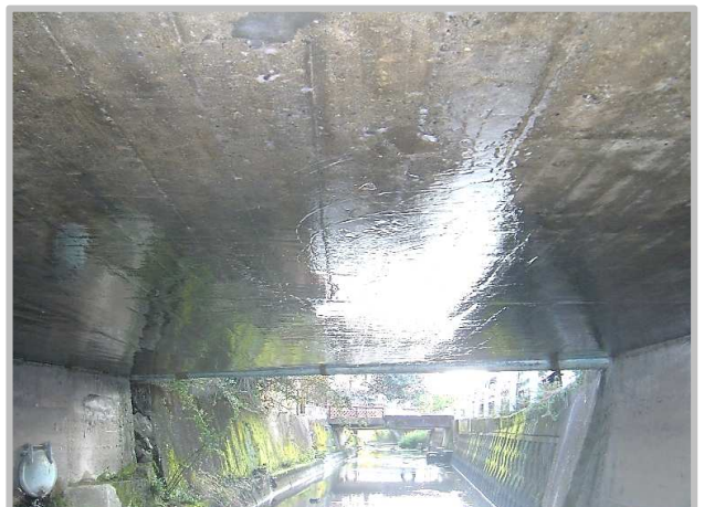
⑥ 施工完了
