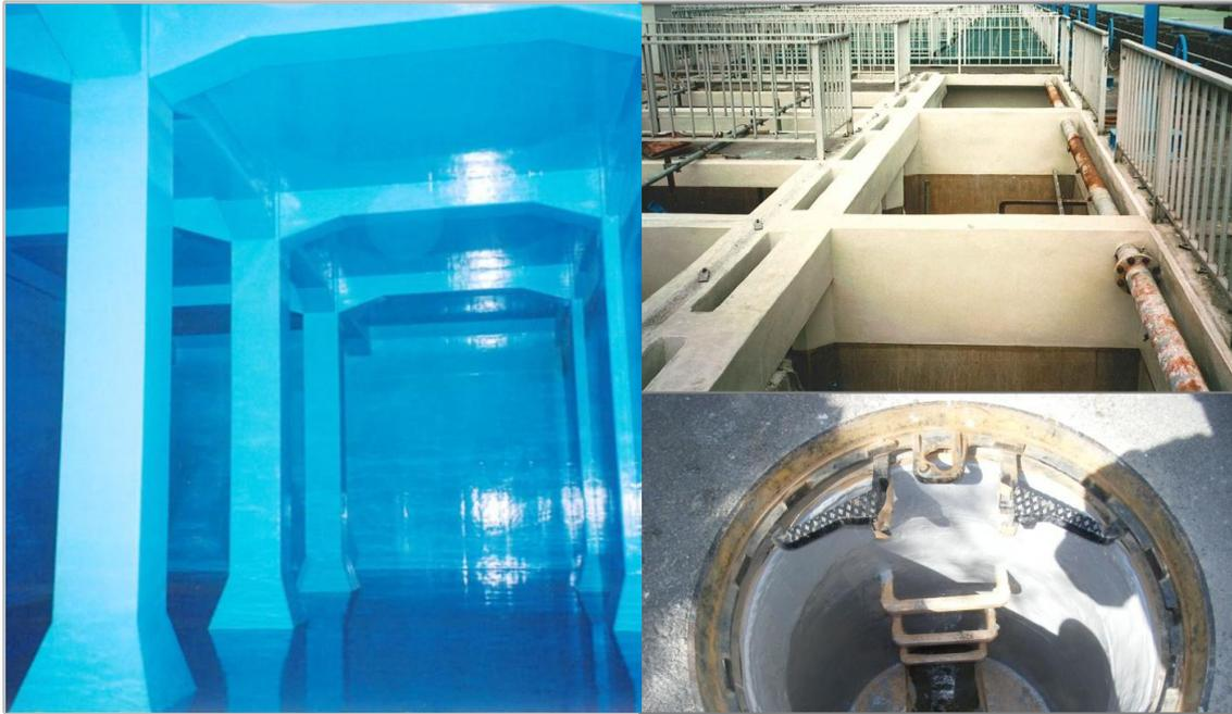
VER防食工法は、エポキシ樹脂をベースとした上下水道向けの塗布型ライニング工法です。用途や施設、施工条件等に
