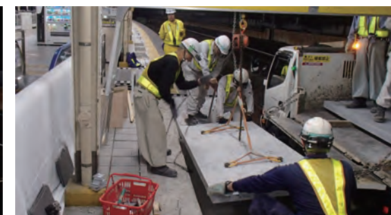
② 人力で据付~ボルト固定
