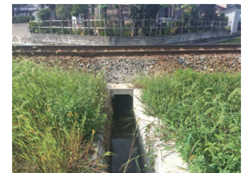
軌道下に、終電から始発までの間で施工
