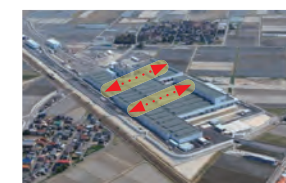
敷地下を横断する排水路
