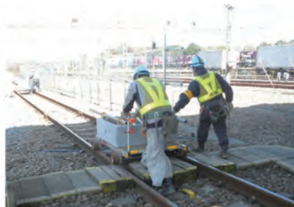
軽量化による施工性向上
