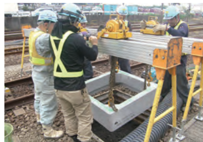
狭隘な用地内での施工
