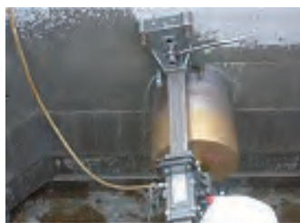
コア削孔状況
