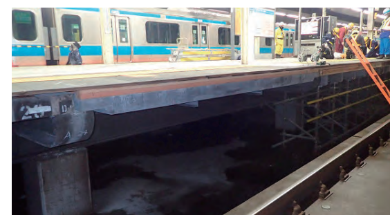
③ スラブ設置完了
