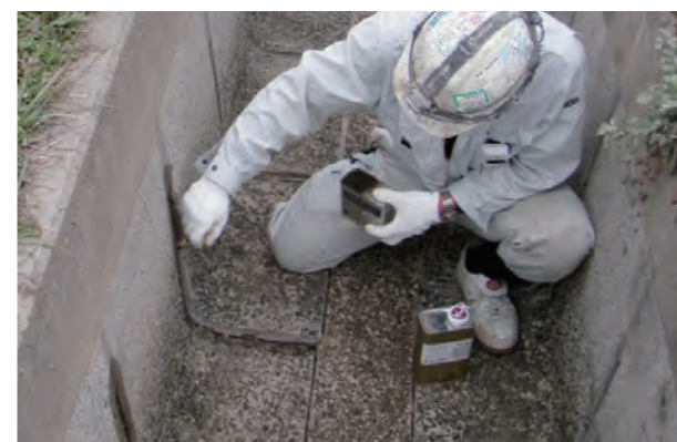
③ プライマー塗布工
