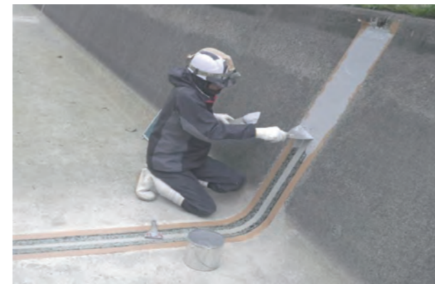
⑤ プライマー塗布工（2次） ⑥ ポリウレア樹脂塗布工
