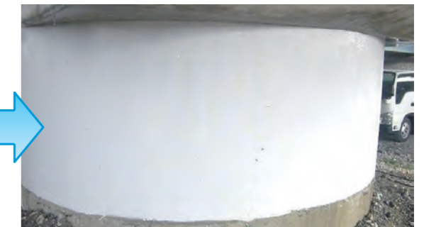
落書き除去（橋脚）施工完了
