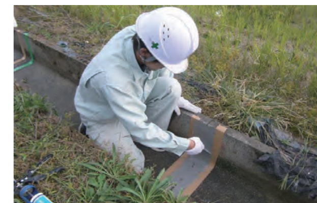
③ シーリング材塗布工
