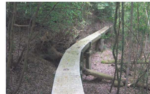
蓋版設置事例
