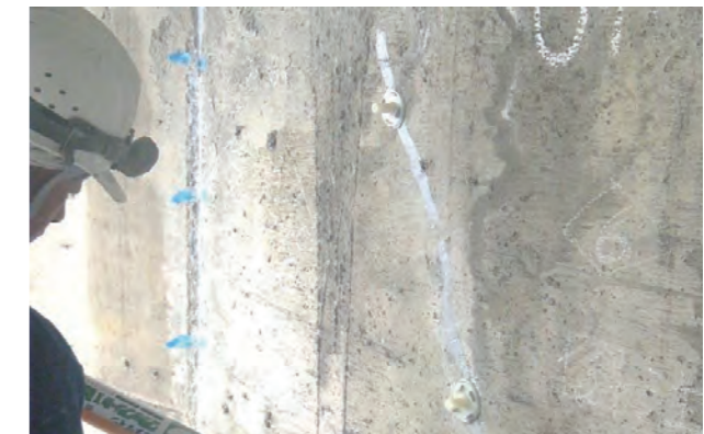
②シール工 座金設置工
