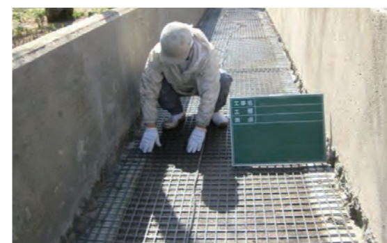
FRP格子筋設置工
