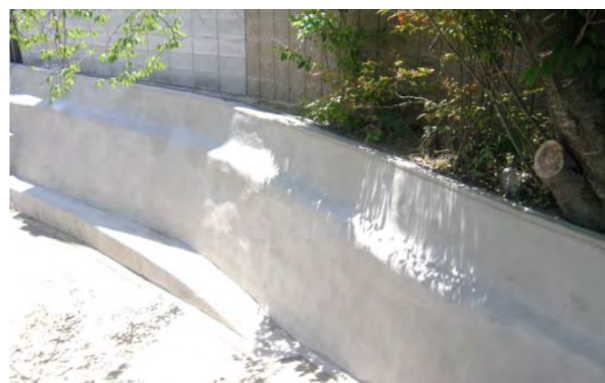
⑤ 施工完了
