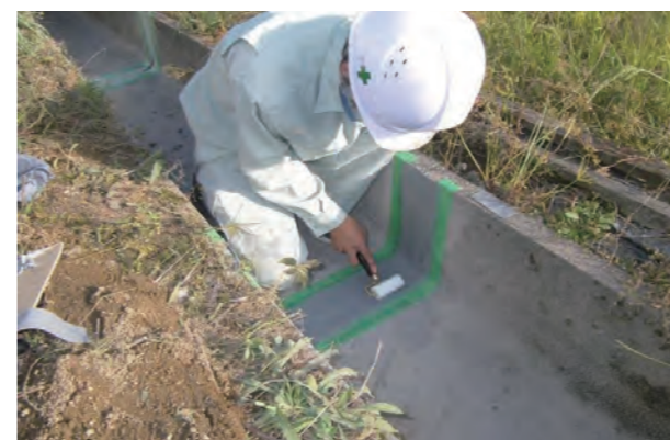
④ シート貼付工
