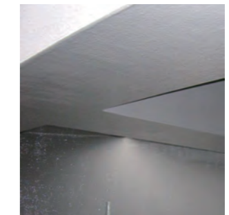
農業集落排水処理施設 （エポマー NW）
