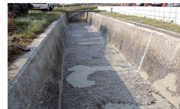
② 断面修復工
