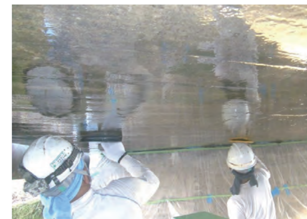
④ 表面被覆工(床版下面)
