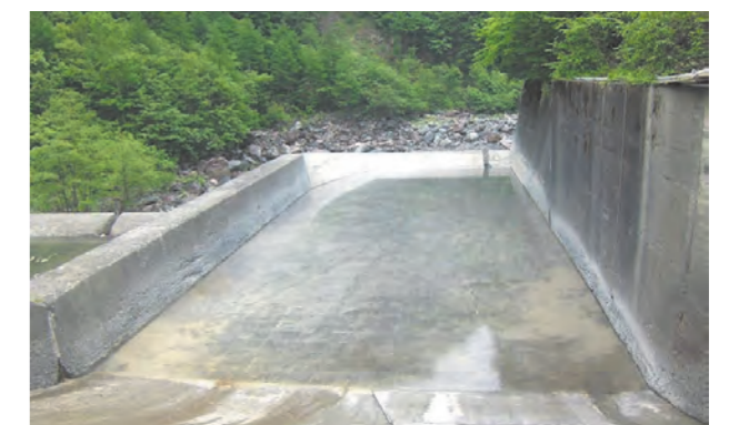
ダム：土砂吐け部
