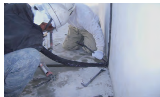
目地材挿入工 （直角部：90°についても一物施工可）
