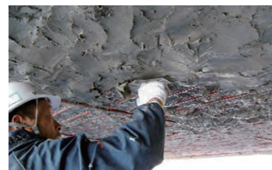
③ 断面修復（ASモルタルT）
