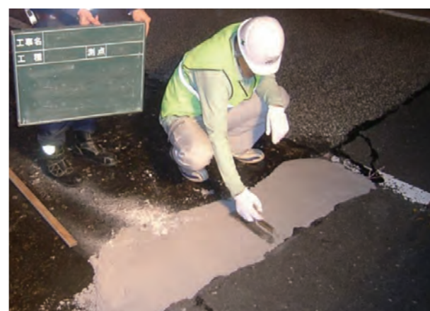
MMA樹脂モルタル打設
