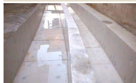
農業水利施設補修
