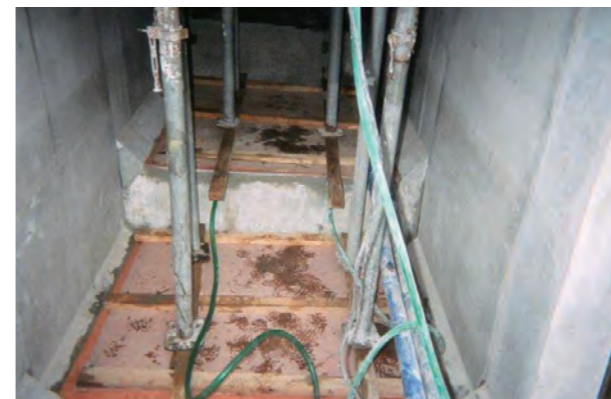
③ 型枠・支保・グラウト工
