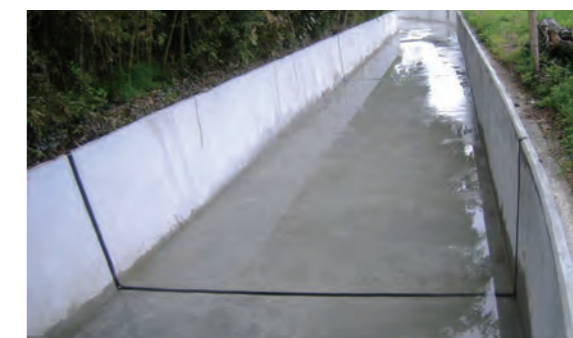
施工完了 （ASモルタル工法との併用）
