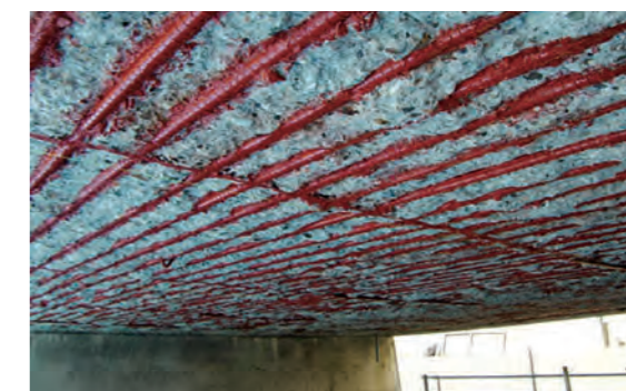
② 防錆材塗布
