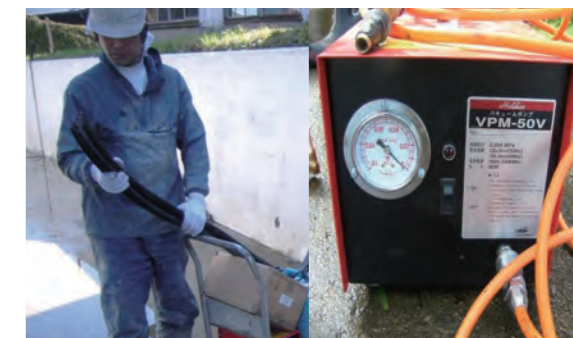
目地材吸引工（右：吸引ポンプ） （吸引ポンプによる目地材内空気の吸引）
