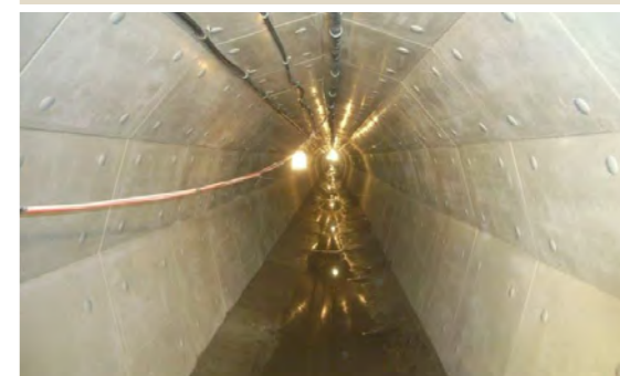
導水路トンネル補強
