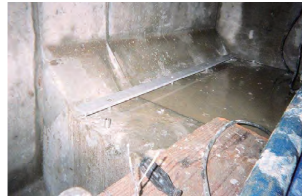
① アンカー・基準枠設置工
