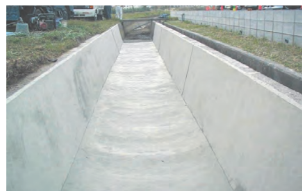
③ 不陸調整工
