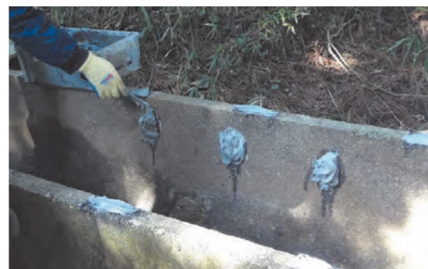
③ プライマー・接着剤塗布工
