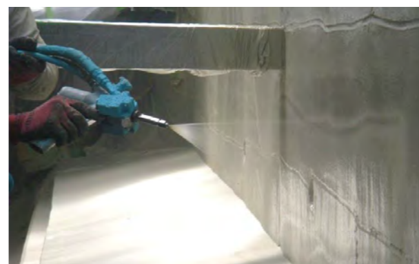
⑤ ポリウレタン樹脂吹付け工
