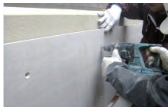
アンカー工(削孔状況)
