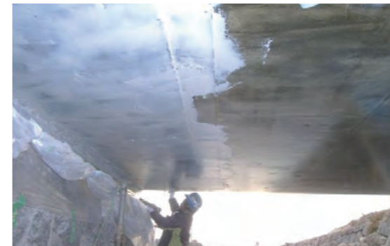
③ プライマー塗布工 ④ 不陸修正工
