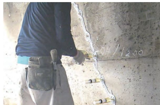
③エポキシ樹脂注入工
