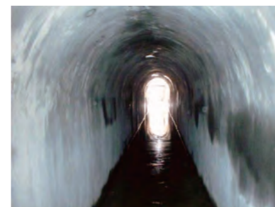
導水路トンネル補修
