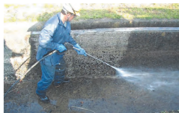
① 下地処理工（高圧洗浄）
