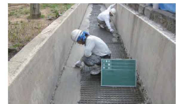
ポリマーセメントモルタル塗布工
