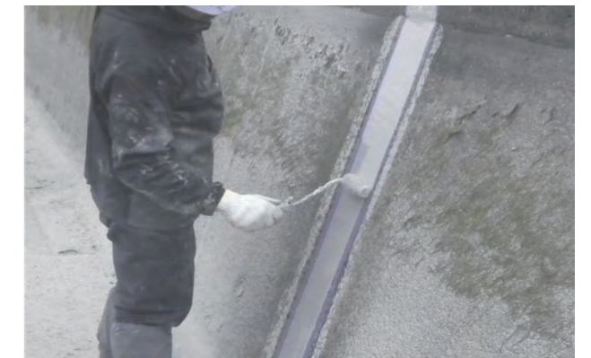
⑦ トップコート塗布工
