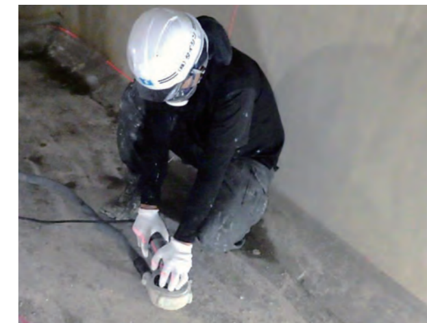
下地処理工 (ケレン工)
