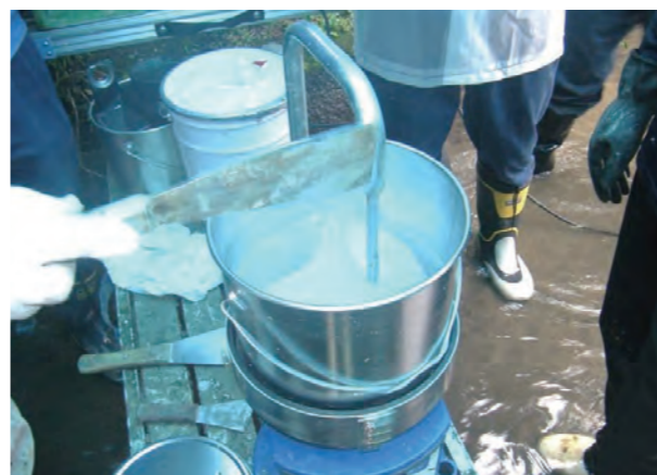
③ 材料攪拌状況
