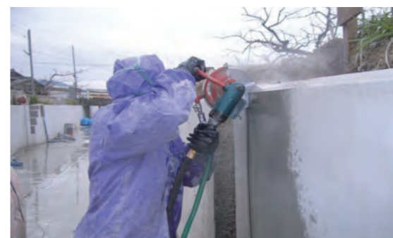
カッター工 （Wカッター：乾・湿両用）
