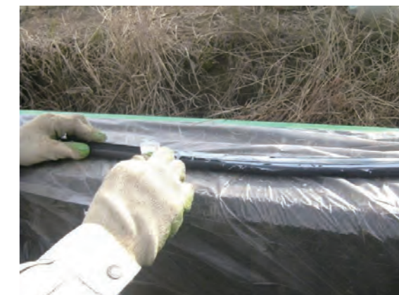
接着剤塗布工 (接着剤塗布状況)
