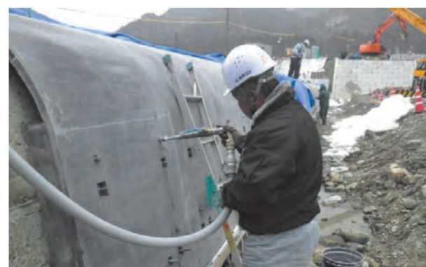
⑤ 無収縮グラウト充填工
