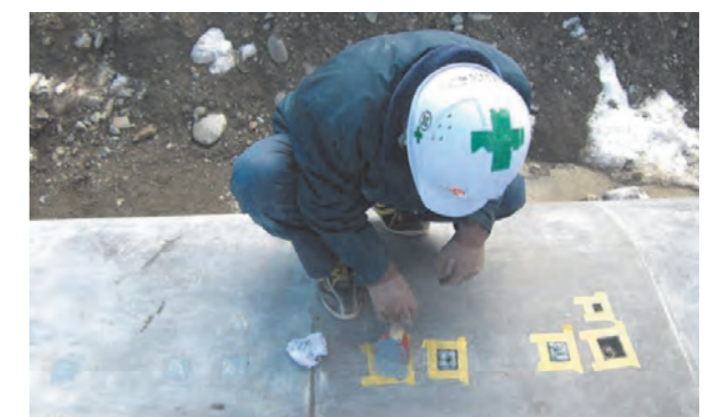
⑥ 仕上げ工（充填材充填）
