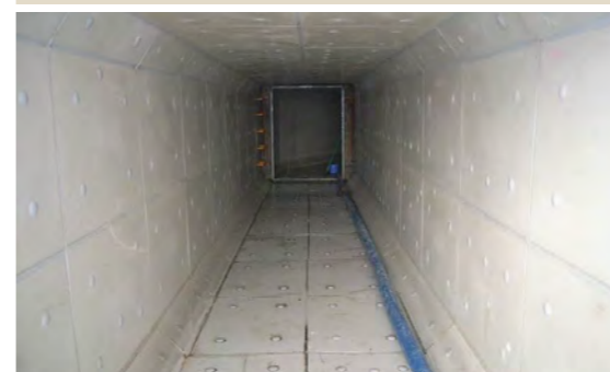
下水処理施設補修
