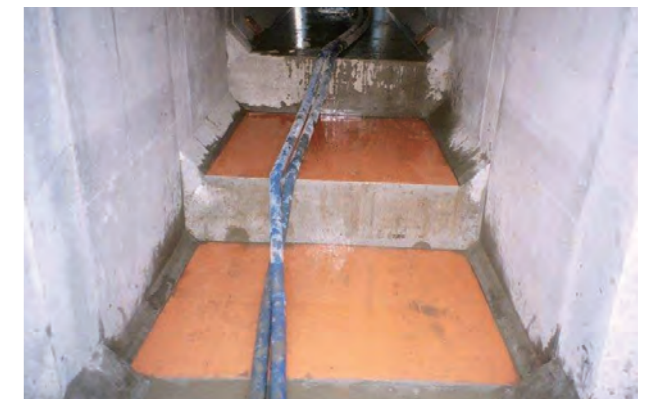
④ 施工完了
