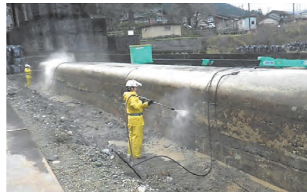
① 下地処理工（高圧洗浄）
