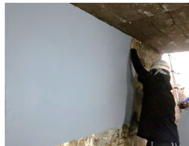
シート貼付工
