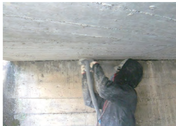
① 下地処理工(ケレン工)
