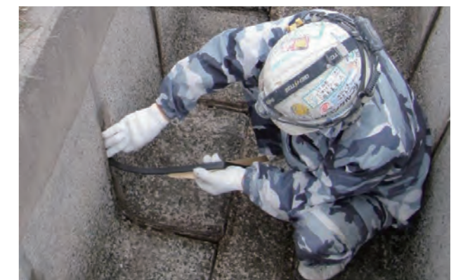
② バックアップ材装填工
