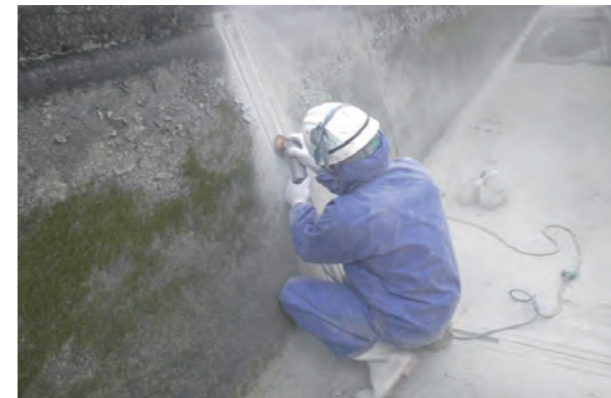
① U型溝成形工 ② 切削工
