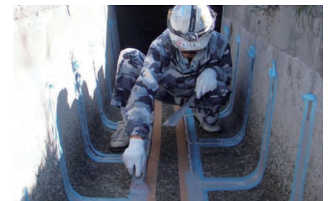
④ シーリング材充填工
