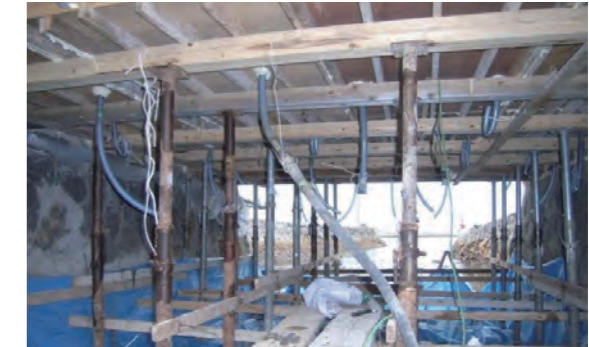
② 断面修復工 (型枠+ポリマーセメントグラウト充填)
