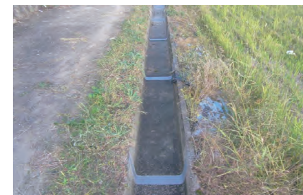
⑤ 施工完了
