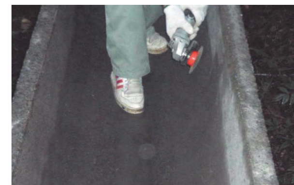
② 下地処理工 (ケレン・高圧洗浄)
