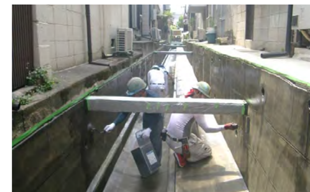
④ プライマー塗布工
