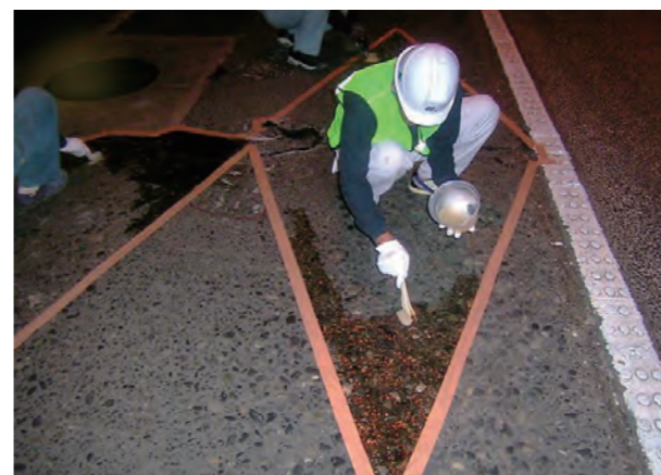
プライマー塗布工
