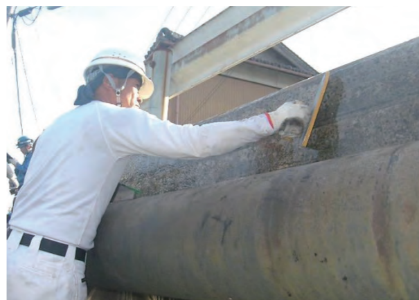
⑤ 表面被覆工(地覆)
