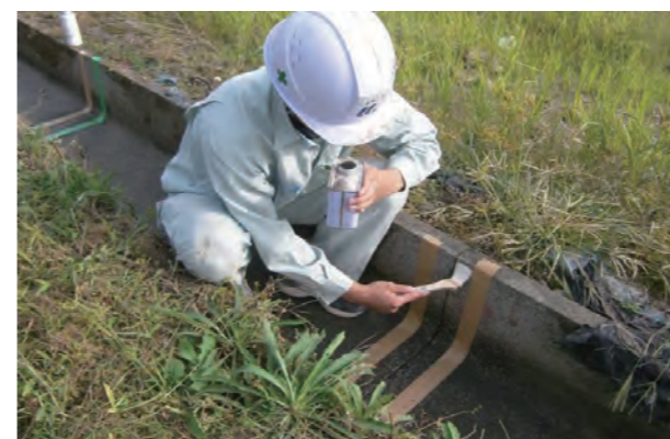
② プライマー塗布工
