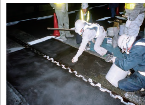
MMA樹脂モルタル打設
