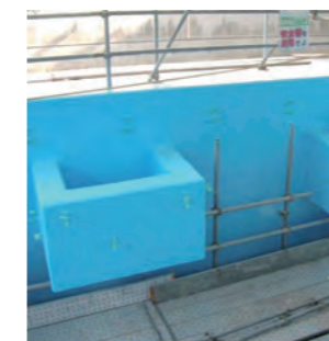
上水用ライニング工法 （エポマー P-800）
