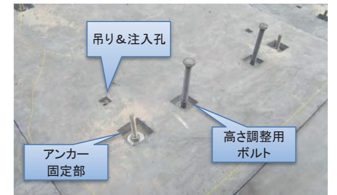
④ パネル設置工（パネル固定）
