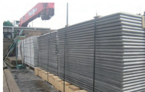
材料搬入(緩衝材付きパネル)
