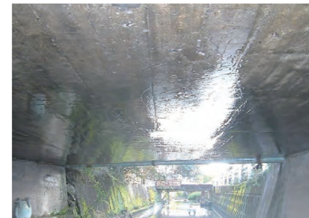
⑥ 施工完了
