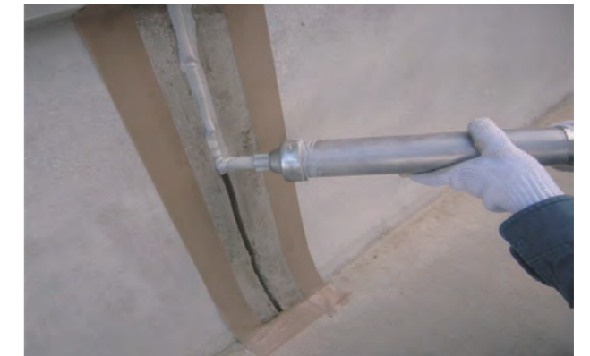
③ プライマー塗布工（1次） ④ シーリング材充填工
