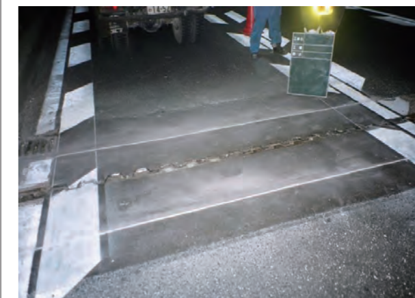
施工完了 (橋梁伸縮装置嵩上げ工法)
