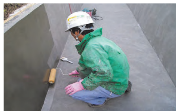
⑤ プライマー塗布工
