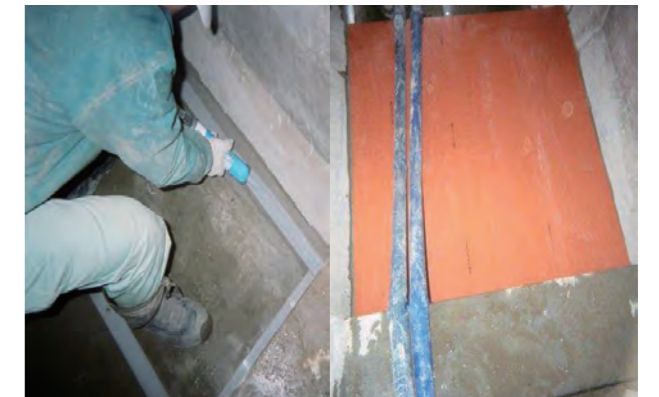
② プレート貼付工
