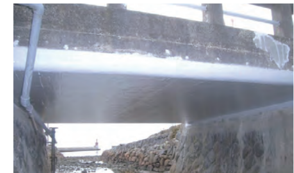
⑧ 施工完了
