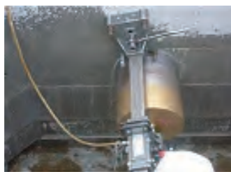
コア削孔状況
