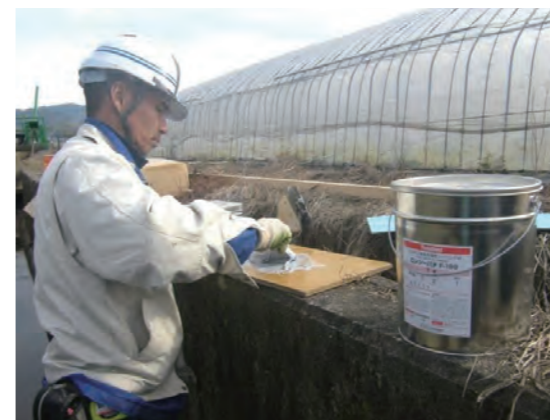
接着剤塗布工 (接着剤混練状況)
