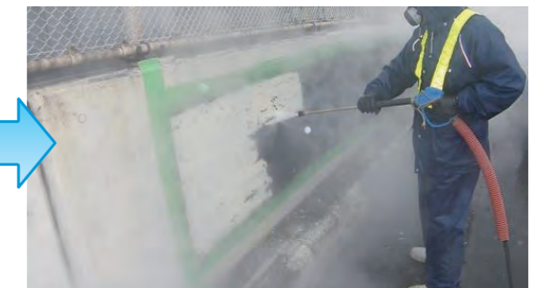
施工状況（加圧高温水洗浄状況）
