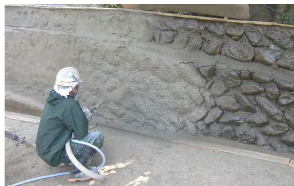
③ 吹付施工
