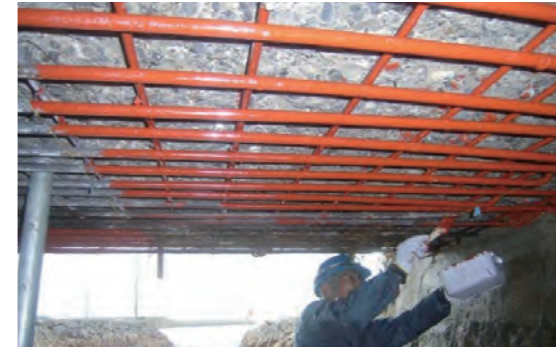
① 防錆材塗布工 (はつり後)
