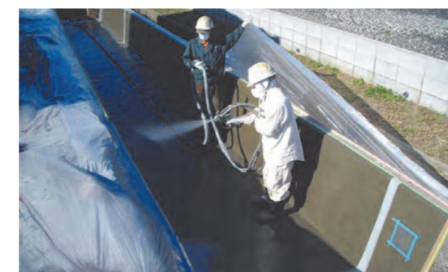
⑥ ポリウレア樹脂吹付け
