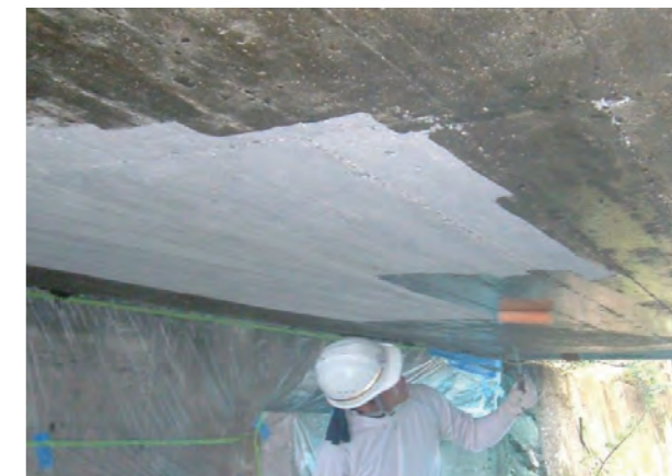
② プライマー塗布工
