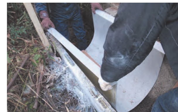
④ FRPフリュームカバー設置工
