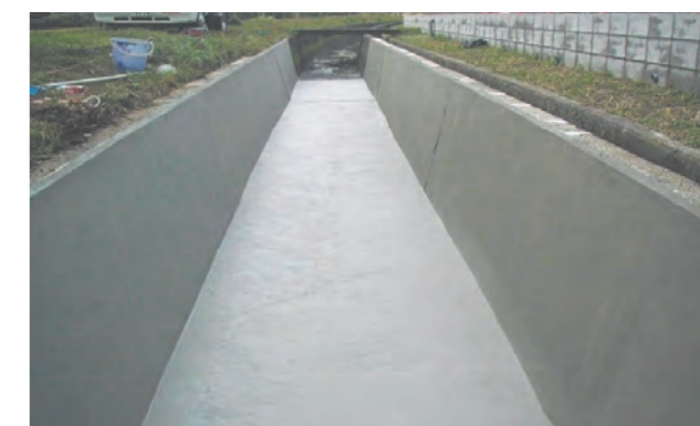
④ 素地調整工
