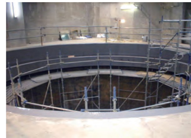
エポマー GW-202-D工法 規格：D種適合工法 （ノンクロス仕様）
