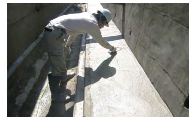
② 不陸調整工
