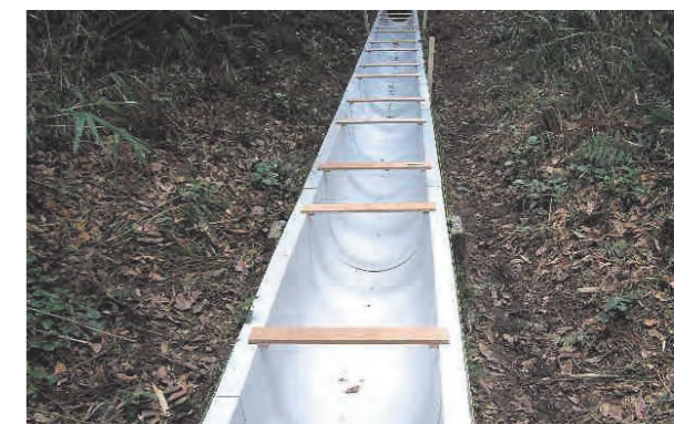
⑥ 養生状況
