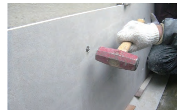
アンカー工(打設状況)
