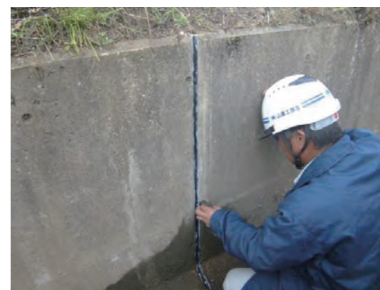
成型ゴム挿入工 (直角部：90°についても一本物施工可)
