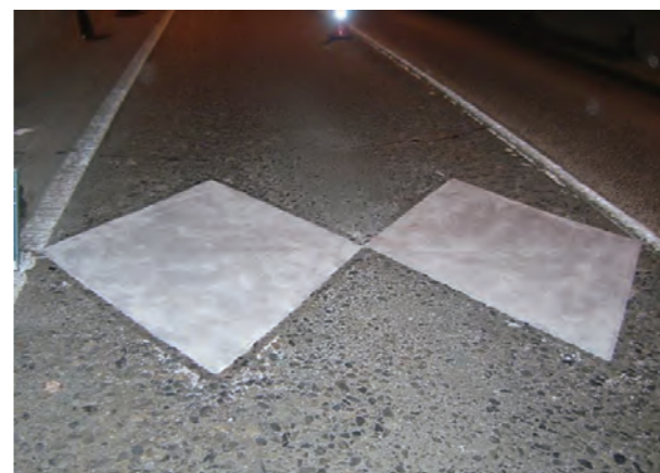
施工完了 (薄層補修工法)
