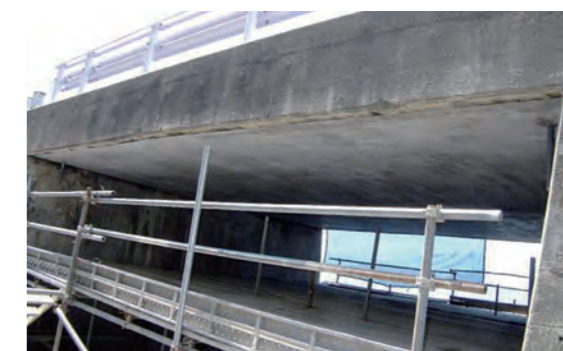
④ 施工完了
