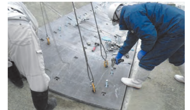
② パネル設置工（高さ調整）
