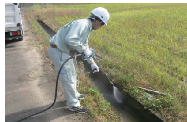
① 下地処理工 (高圧洗浄)
