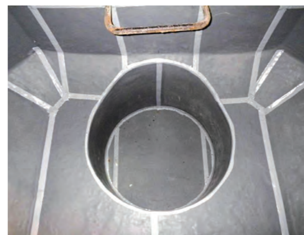
ピット部施工状況
