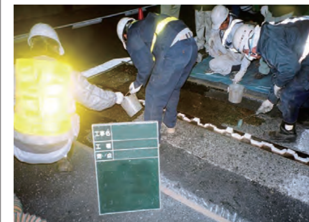
プライマー塗布工
