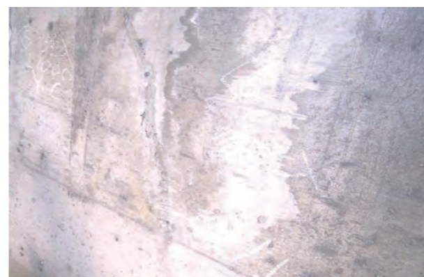
⑤施工完了
