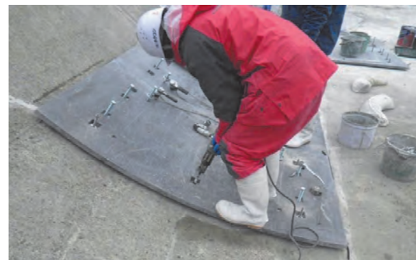
③ アンカー工
