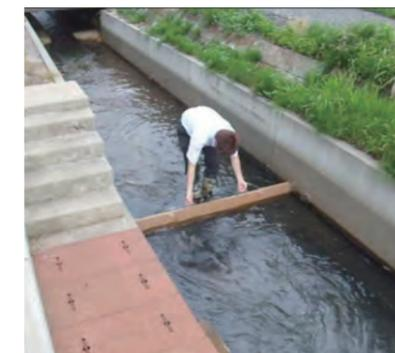
堰板を設置する事により、うろ部への水流を発生させて掃流力を利用し、簡単に溜まった土砂を取り除く事ができます。
