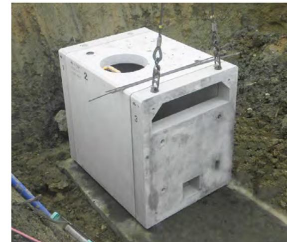
ボックス貯留槽の越流壁としての事例
