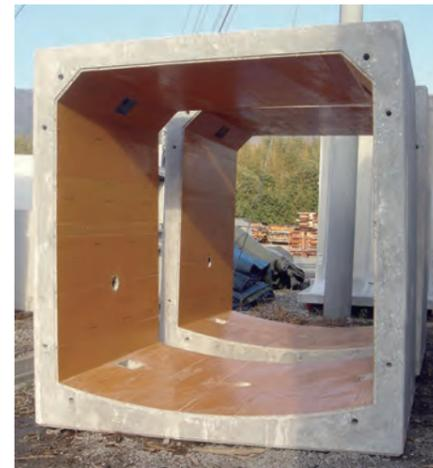
コンクリート下水道管路・構造物等を合成樹脂プレートで保護するシートライニング工法であり、1997年には日本下水道事業団の「コンクリート防食指針(案)」に当工法が採用されています。
