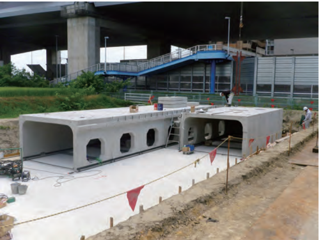
施工場所：愛知県内 内空高さ：H-1500 貯留容量：280m 3
