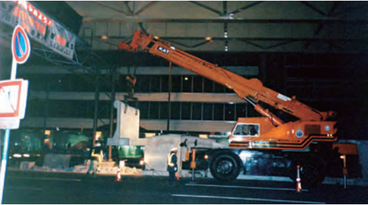
L型擁壁 荷卸し状況
