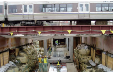
鉄道高架下人道ボックス工事
