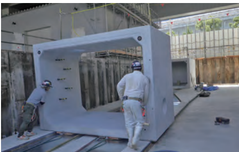
鉄道高架下雨水貯留槽工事
