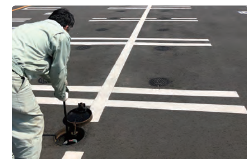
密閉式排出バルブ・注水バルブは地上部より操作。(専用治具付属)
