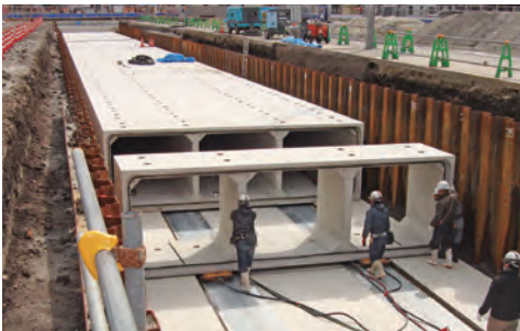
雨水貯留槽工事
