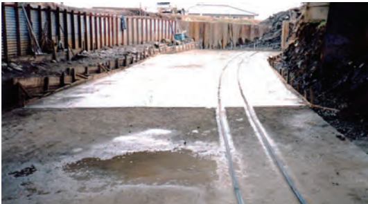
基礎鋼材 設置状況
