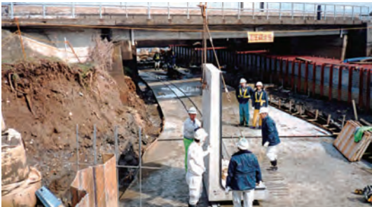
移動台車に設置状況
