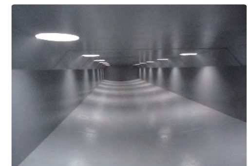
内部は特殊コーティングにより、再利用可能。インバート構造で流下・洗浄性を向上。
