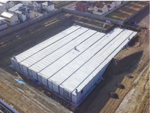
施工場所：兵庫県内 内空高さ：H-4500 貯留容量：10000m 3
