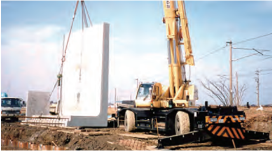
L型擁壁 荷卸し状況
