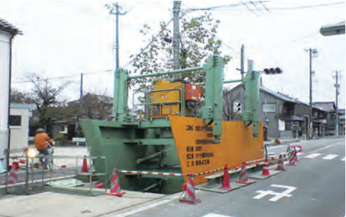
組立状況（自降装置装着）
