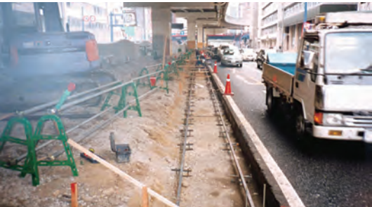
基礎鋼材 設置状況
