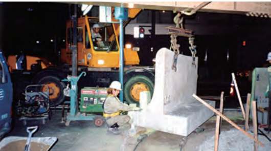
移動台車に設置状況
