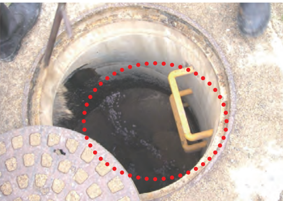
目詰まりにより使えなくなった 前処理を行なわない浸透マンホール
