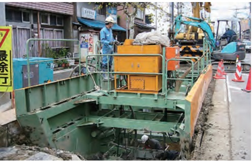
埋め戻しを反力としOSJ機の推進状況
