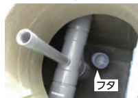
人孔から付属の棒でフタを突いて外すと、貯留槽に汚水を貯留できます。
