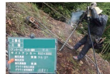
ロックバリアアンカー削孔
