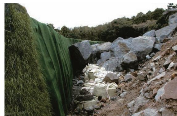
落石を受けた後の落石防護補強土壁
