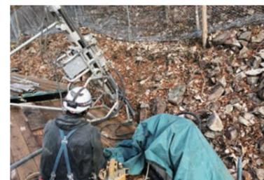
MJネットアンカー削孔
