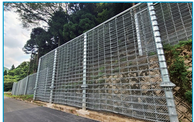
発注者 西日本高速道路株式会社 工事件名 舞鶴若狭自動車道(特定更新等)春日IC~大飯高浜IC間盛土補強工事 施工箇所 京都府舞鶴市字上根地内 施工延長 225m 落石エネルギー 949kJ
