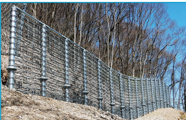
発注者 長野県上田建設事務所 工事件名 令和2年度 防災・安全交付金(急傾斜地崩壊対策)(緊急対策事業)工事(急)和子 上田市 和子 施工箇所 長野県上田市和子 施工延長 40m 落石エネルギー 1007kJ
