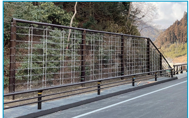
発注者 福島県いわき建設事務所 工事件名 道路橋りょう整備(再復)工事(道路改良) 施工箇所 福島県いわき市田人町石住字才鉢地区 施工延長 18m 落石エネルギー 135kJ
