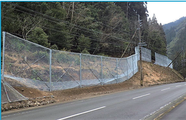
発注者 宮崎県日向土木事務所 工事件名 令和2年度防国法面第955-9-17-2号国道446号小又吐工区道路防災工事(その2) 施工箇所 宮崎県東臼杵郡美郷町南郷大字水清谷 施工延長 130m 落石エネルギー 94kJ
