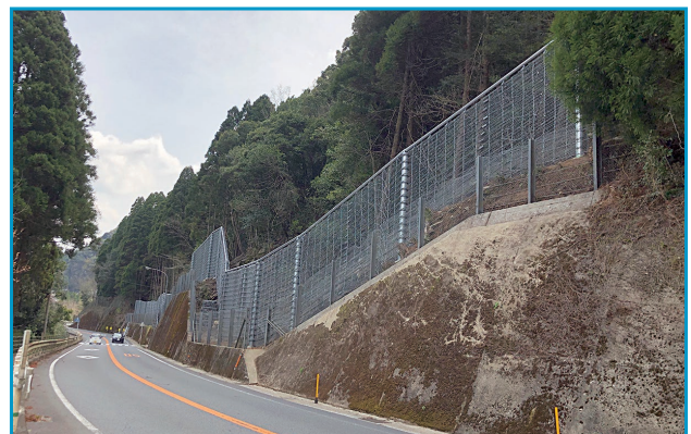
発注者 九州地方整備局 佐伯河川国道事務所 工事件名 令和2年度 尺間地区防災外工事 施工箇所 大分県佐伯市弥生大字尺間 施工延長 138m 落石エネルギー 1189kJ
