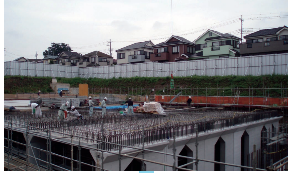
⑦目地防水工
