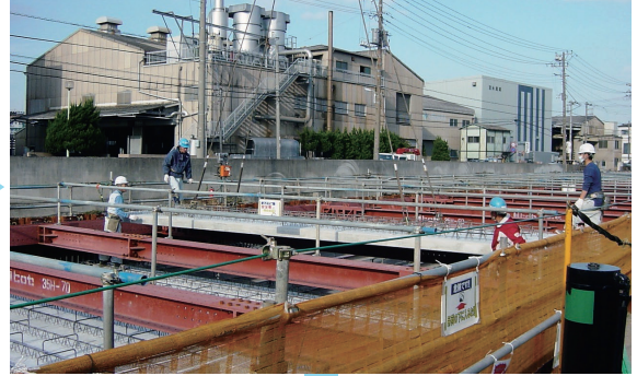
⑤頂版スラブ据付工
