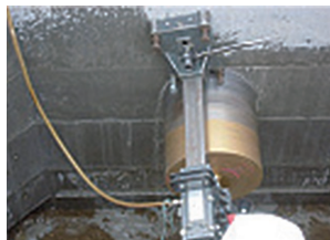
コア削孔状況
