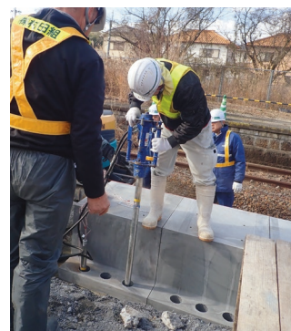
打ち込み杭の施工状況
