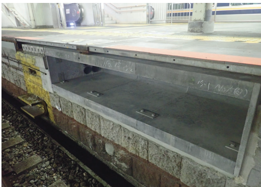
⑤据付完了 (HSモルタル製閉塞パネル)
