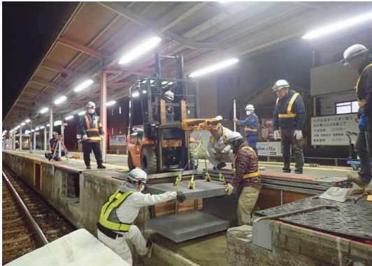
③フォークリフトによる据付
