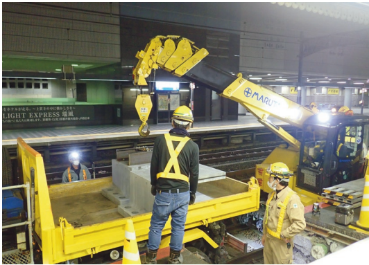
①軌陸車による搬入
