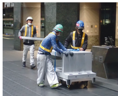
施工台車による人力運搬
