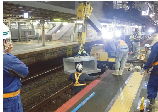
②軌陸クレーンによる据付
