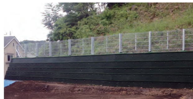
発注者：民間企業 工事件名：図師坂下日影公園土砂災害防止法対策工事 施工箇所：東京都町田市図師町地内 施工延長：41.1m
