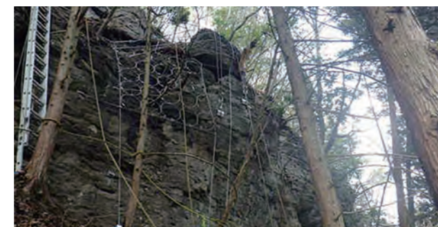
発注者：大分県豊後大野土木事務所 工事件名：平成29年度防安心防第100-2号災害防除工事 施工箇所：大分県豊後大野市朝地町(国道442号)地内 最大岩塊重量：201~669kN
