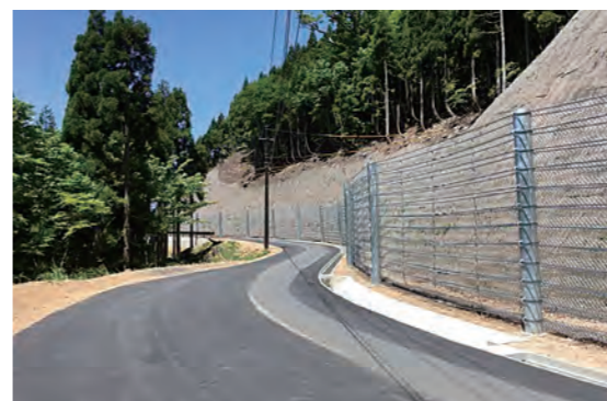
発注者：鳥取県八頭県土整備事務所 工事件名：国道482号道路災害防除工事 (落石防護柵2工区)(交付金防災)(経済対策) 施工箇所：鳥取県八頭郡若桜町春米 施工延長：231m
