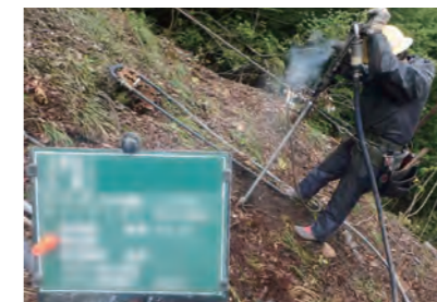
アンカー工（人力削孔）
