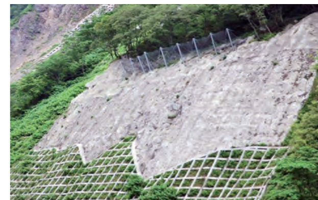
発注者：国土交通省北陸地方整備局松本砂防事務所 工事件名：葛葉下流山腹工法面工その3工事 施工箇所：長野県北安曇郡小谷村大字小谷葛葉地内 施工延長：37.2m
