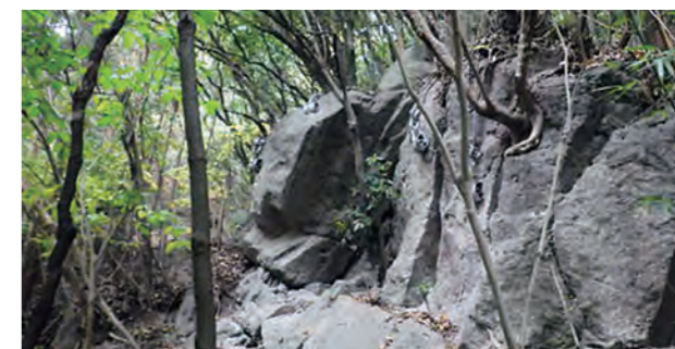
発注者：国土交通省九州地方整備局 長崎河川国道事務所 工事件名：長崎管内南部地区法面補修外工事 施工箇所：長崎県雲仙市小浜町地内 最大岩塊重量：2500kN
