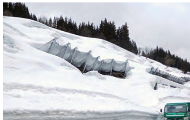
発注者：国土交通省北陸地方整備局長岡国道事務所 工事件名：国道253号八箇地区道路その9工事 施工箇所：新潟県十日町市八箇地先 施工延長：28m
