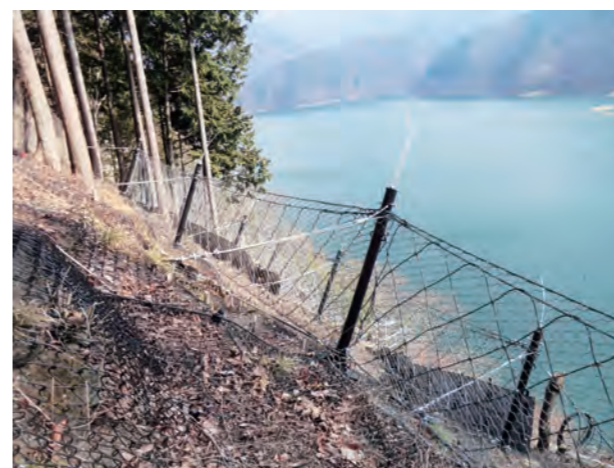
発注者：東京都水道局水源管理事務所 工事件名：朝里1丁目小規模治山工事 施工箇所：東京都西多摩郡奥多摩町原字出野地内 施工延長：42m
