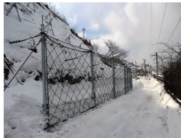
発注者：小樽市役所 工事件名：朝里1丁目小規模治山工事 施工箇所：北海道小樽市朝里1丁目1番地先 施工延長：16.5m
