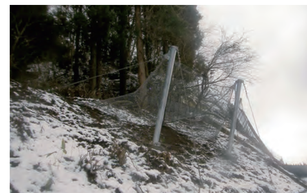
発注者：福島県喜多方建設事務所 工事件名：生活基盤緊急改善工事 施工箇所：福島県耶麻郡北塩原村大字大塩字桜峠地内 施工延長：4.5m
