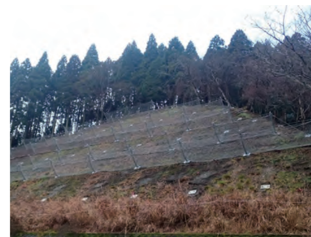
発注者：滋賀県高島土木事務所 工事件名：平成27年度国道303号補助雪寒対策工事 施工箇所：滋賀県高島市今津町保坂地内 施工延長：162+84m
