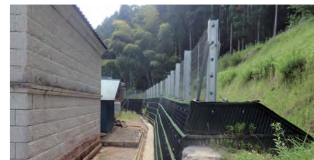
発注者：栃木県宇都宮土木事務所 工事件名：平成22年度急傾斜地崩壊対策工事 施工箇所：栃木県宇都宮市徳次郎町上田中地内 施工延長：32m
