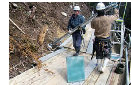
落石防護柵支柱建込
