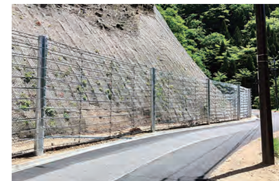
発注者：鳥取県八頭県土整備事務 工事件名：国道482号道路災害防除工事 (落石防護柵1工区)(交付金防災)(経済対策) 施工箇所：鳥取県八頭郡若桜町春米 施工延長：112.5m
