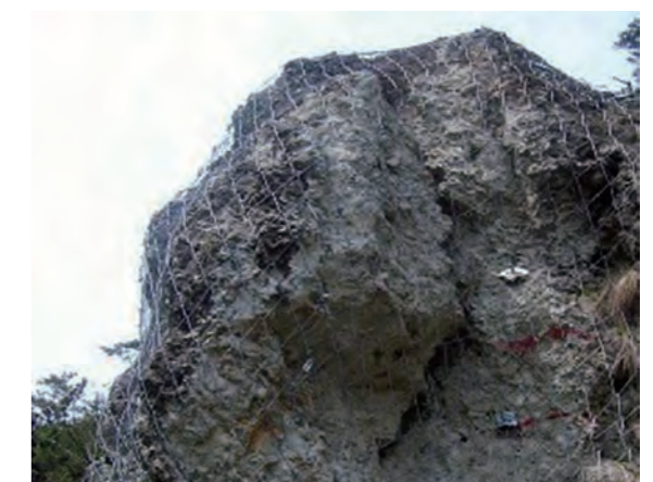
施工事例 (パワーネット (落石予防))
