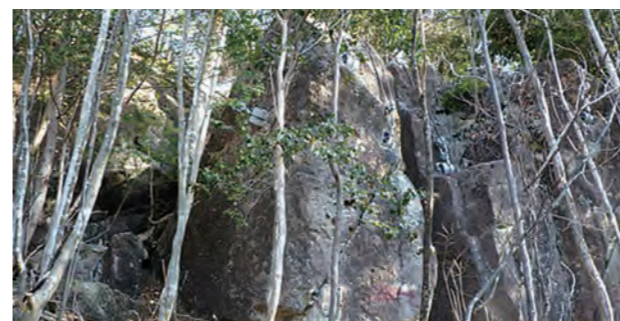
発注者：岐阜県下呂土木事務所 工事件名：公共道路災害防除施設(国補正分)工事 施工箇所：主要地方道宮萩原線下呂市萩原町山之口(1)地内 最大岩塊重量：340~3190kN
