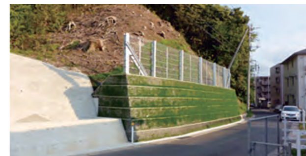
発注者：島根県松江市役所 工事件名：楽山公園斜面崩壊対策その4工事 施工箇所：島根県松江市西川津町 施工延長：17.1m
