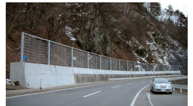
岩手県 国道106号 箱石地区落石対策工事
