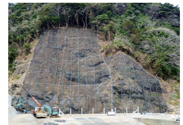
覆式防護網として使用した事例
