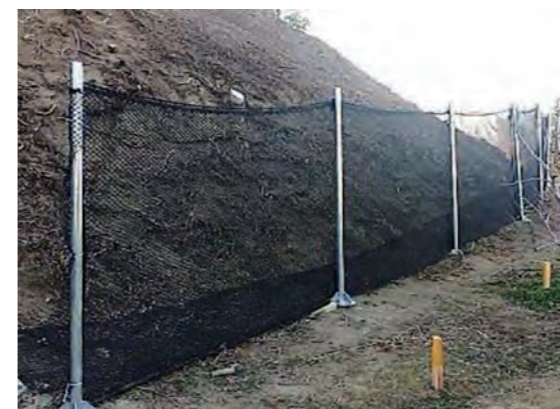
防護柵として使用した事例
