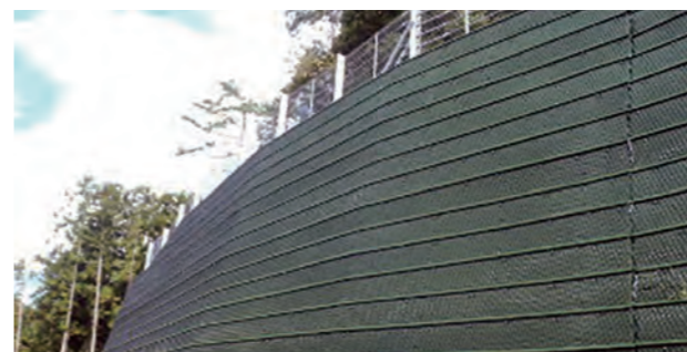
発注者：栃木県土整備部安足土木事務所 工事件名：擁壁工事磯川原Aその1(補助砂防) 施工箇所：栃木県佐野市水木町 施工延長：44.8m
