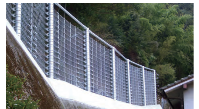
山口県 乙瀬 (1) 地区急傾斜地崩壊対策工事第1工区
