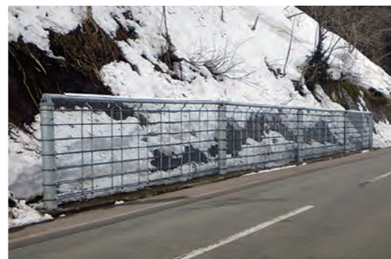
発注者：秋田県雄勝地域振興局 工事件名：県単道路補修工事(災害防除) 施工箇所：秋田県湯沢市稲庭字岩城 施工延長：32m
