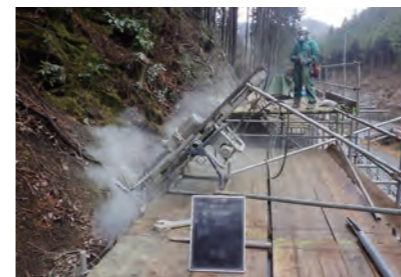
アンカー工（軽量ボーリングマシン）
