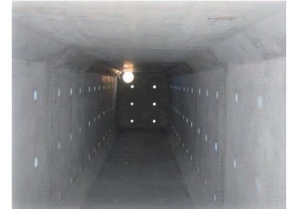
浸透機能を付加したボックス貯留槽の内部
