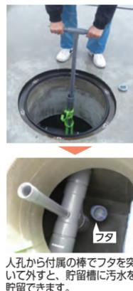
人孔から付属の棒でフタを突いて外すと、貯留槽に汚水を貯留できます。
