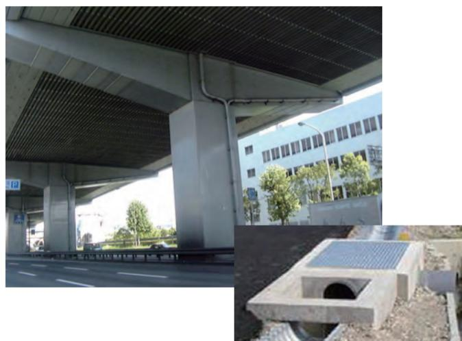
高架部の路面排水の汚濁物を『れいんクル』で除去してから排水又は、地下浸透させます。
