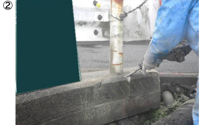
研り工(断面修復工)
