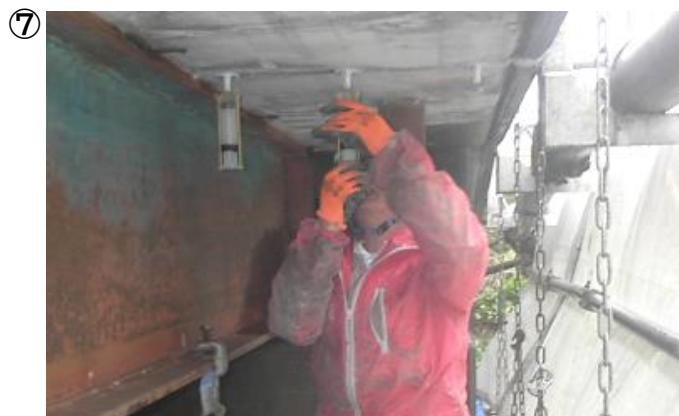
エポキシ樹脂注入工(ひび割れ注入工)
