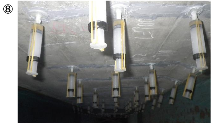
エポキシ樹脂注入工(ひび割れ注入工)
