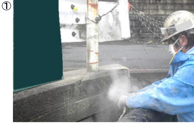
カッター工(断面修復工)
