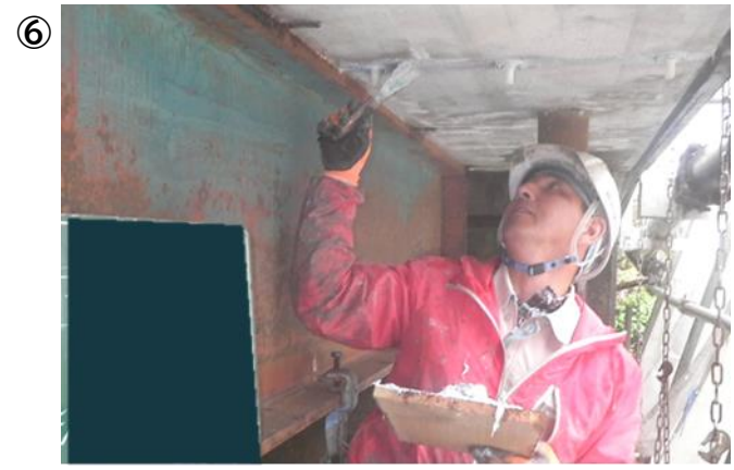
シーリング工(ひび割れ注入工)
