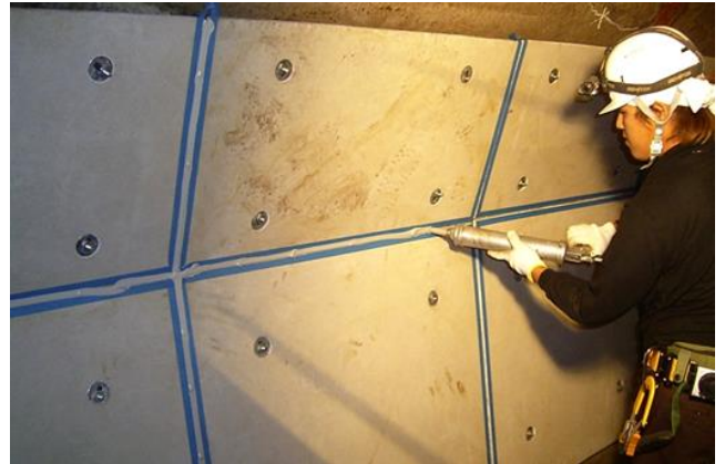
パネル目地工
