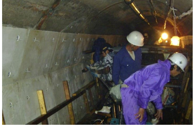
パネル設置工(側部)
