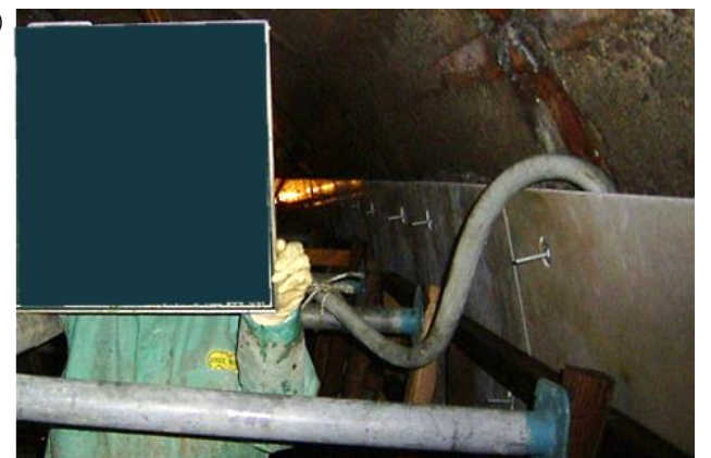
無収縮モルタル充填工
