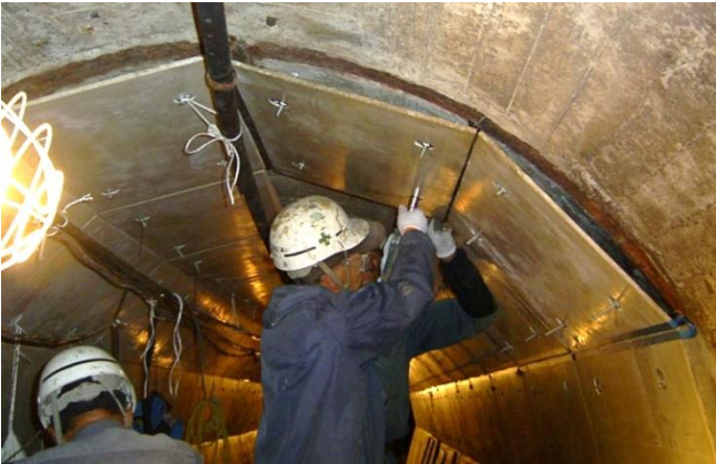
パネル設置工(上部)
