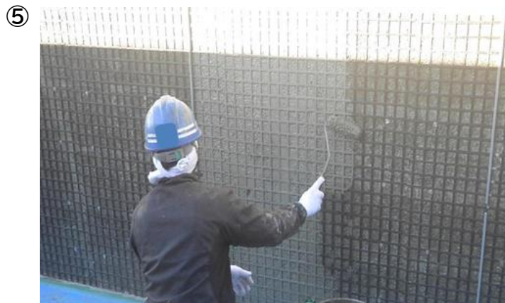
プライマー塗布工
