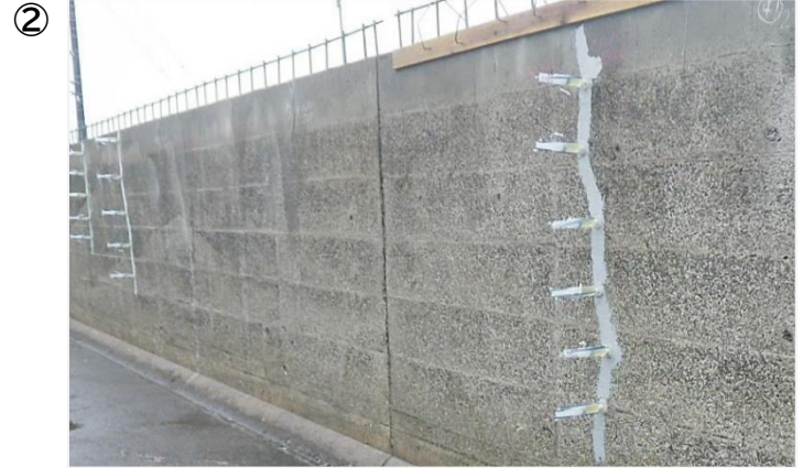
ひび割れ補修工(樹脂系ひび割れ注入工法)
