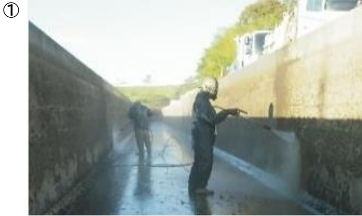
高圧水洗浄工(50MPa)
