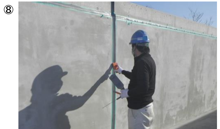
目地補修工(目地充填工法)
