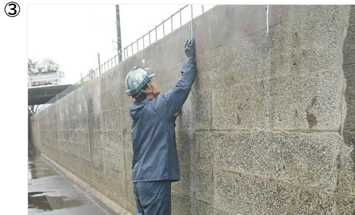
ひび割れ補修工(可とう性エポキシ樹脂充填工法)
