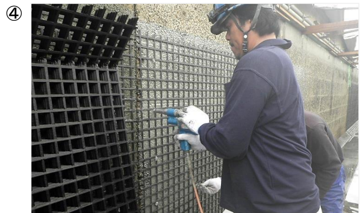
FRPグリッド設置工
