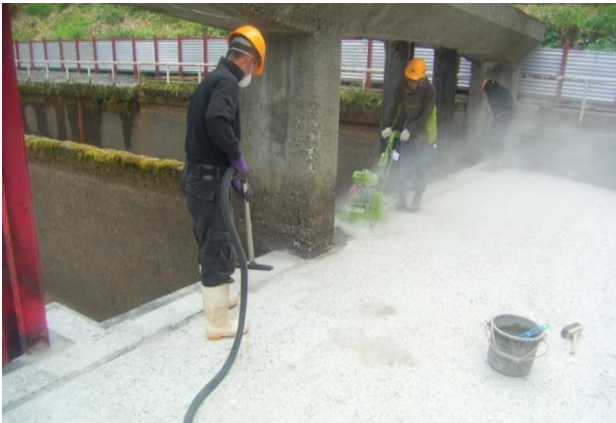
切削工(沈砂池)
