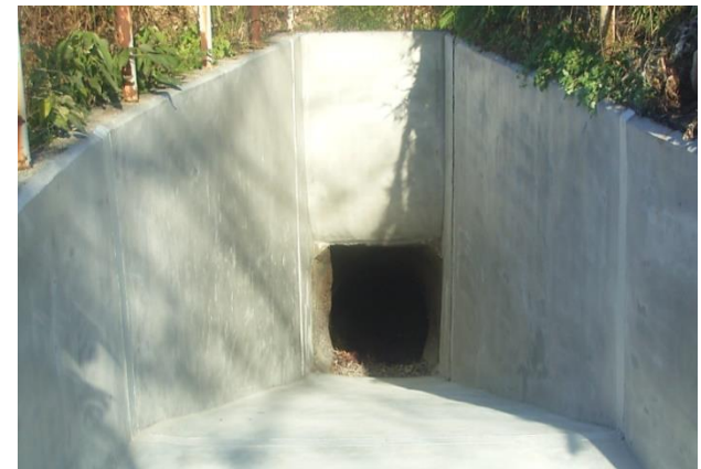
施工完了(水路)
