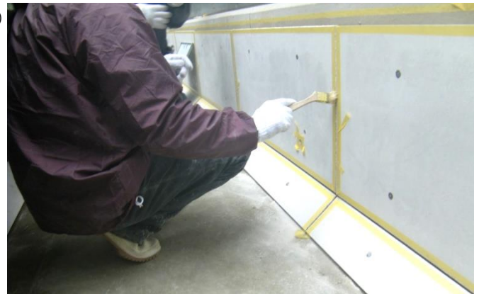
パネル目地工(プライマー塗布)
