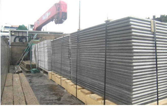
材料搬入(緩衝材付きパネル)
