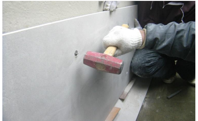
アンカー工(打設)
