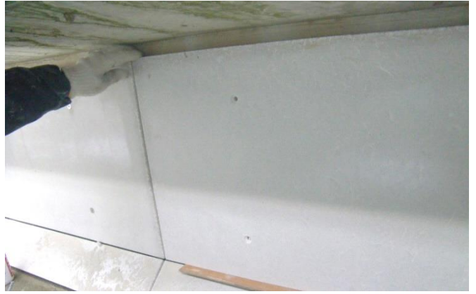
パネル組立工
