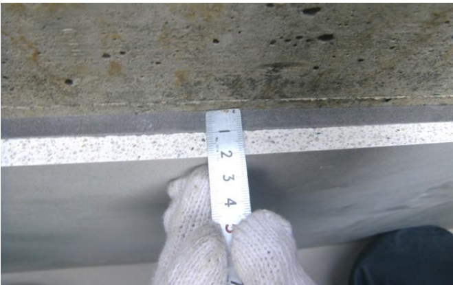
パネル:t=10mm+緩衝材:t=10mm
