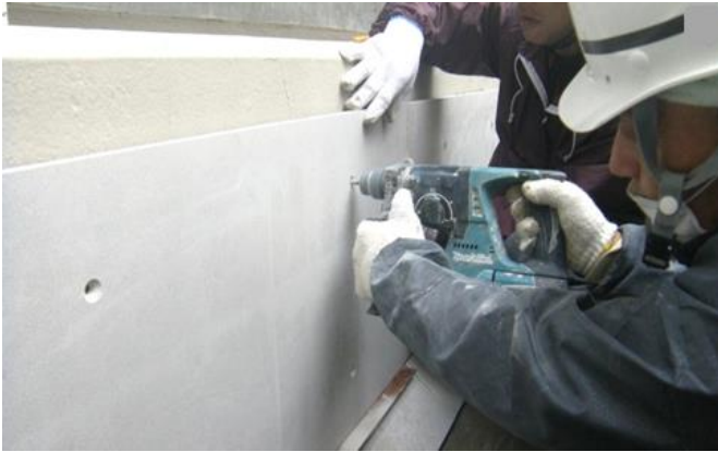
アンカー工(削孔)
