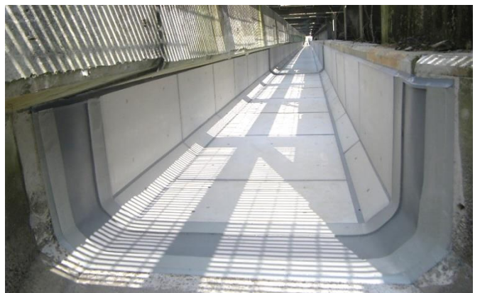
既設目地補修工 ⇒ 施工完了
