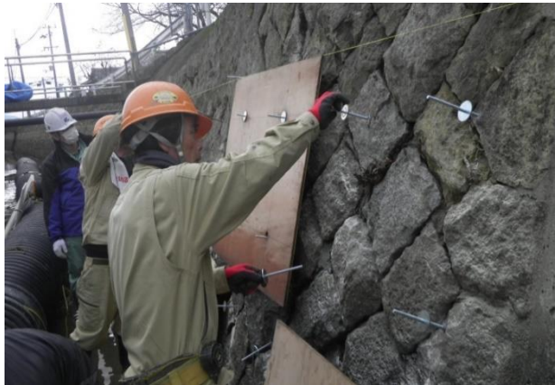
パネル設置工(副資材)
