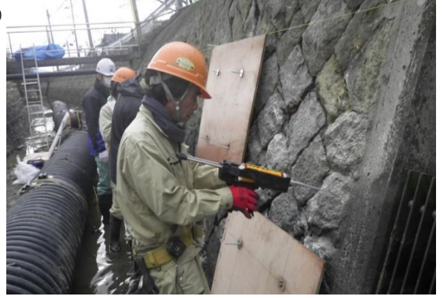
アンカー工(打設:樹脂アンカー仕様)
