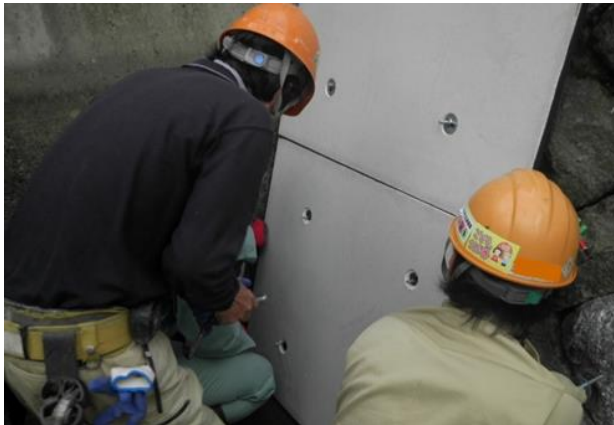
パネル設置工
