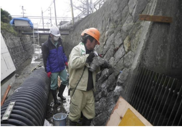
アンカー工(穿孔)
