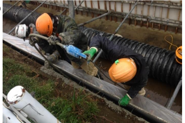
コンクリート打設工(コンクリートポンプ車打設)
