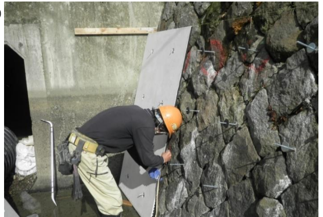
パネル設置工(目地材設置)
