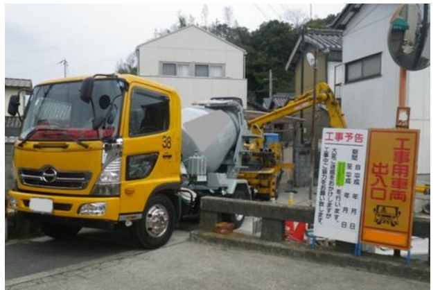
裏込注入工(高流動モルタル配合)
