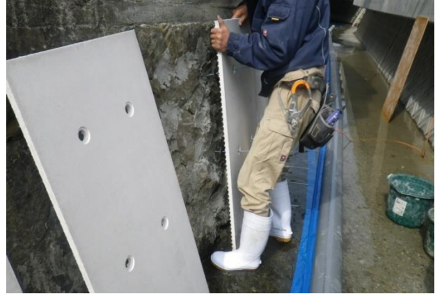
パネル組立工
