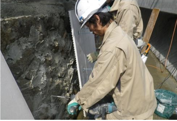
アンカー工(穿孔・打設)
