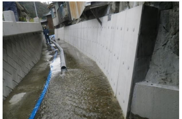
樹脂キャップ取付 ⇒ 施工完了
