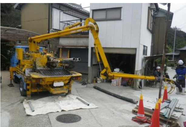
裏込注入工(高流動モルタル配合)
