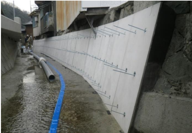
パネル設置完了
