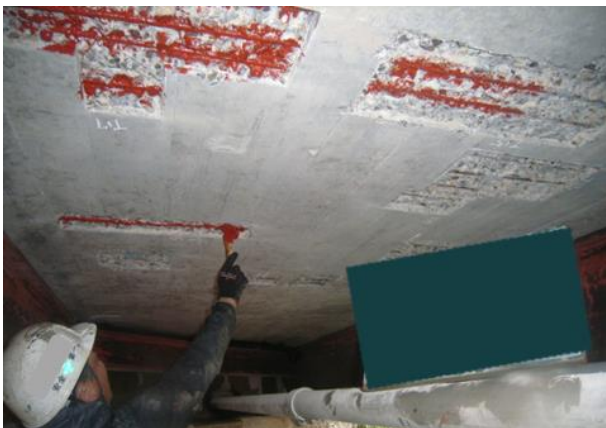
防錆剤塗布工(断面修復工)
