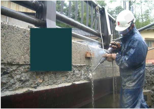
研り工(断面修復工)
