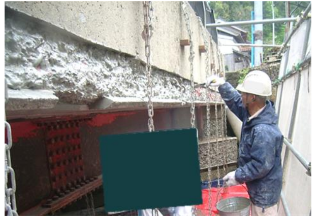
プライマー塗布工(断面修復工)
