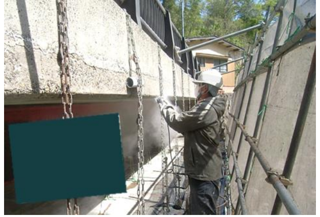
カッター工(断面修復工)
