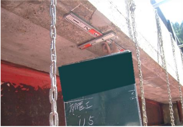
調査工(断面修復工)
