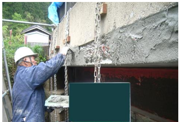
断面修復材塗布工(断面修復工)
