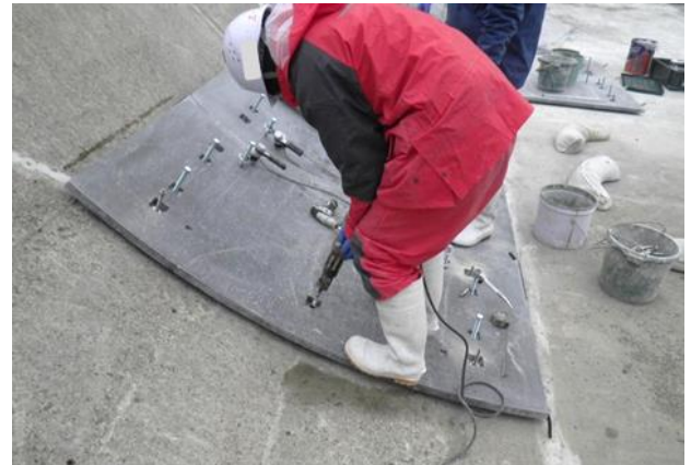
アンカー工(削孔)
