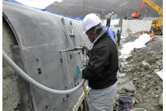
無収縮グラウト充填工
