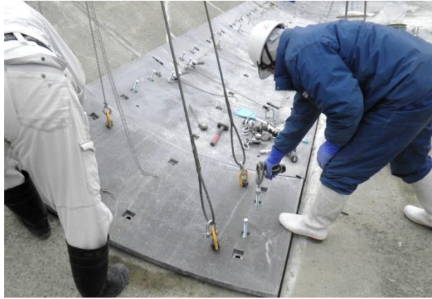
パネル設置工(高さ調整)
