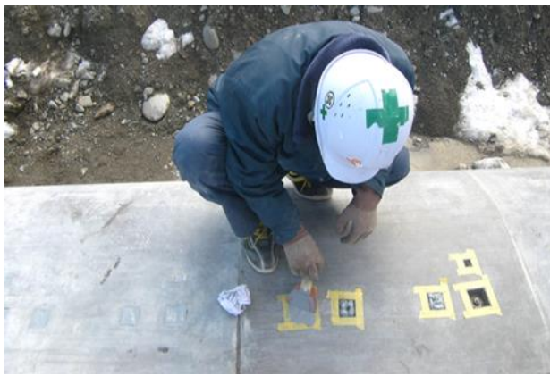
仕上工(シーリング材充填)
