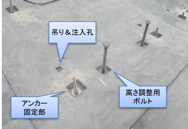
パネル設置工(パネル固定)
