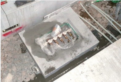
バルブユニットによる流量調整
