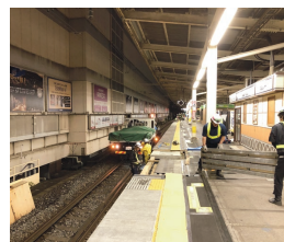
① 仮設材撤去
