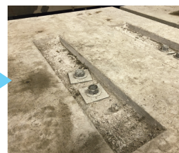
⑤ ボルト締め付け
