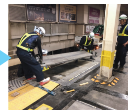
⑥ 仮設材を戻して完了
