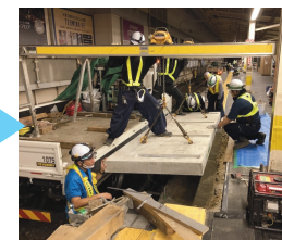
③ 吊り上げ・設置
