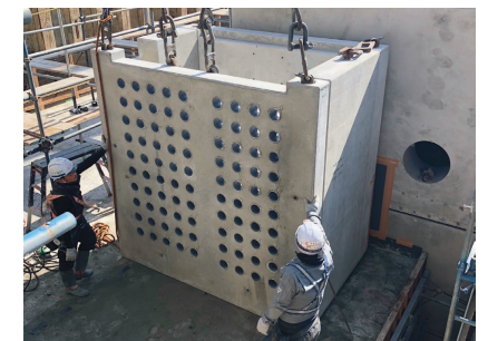
閉塞バネル（塩ビ管理込み）
