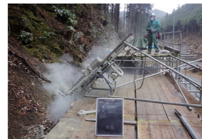
アンカー工（軽量ボーリングマシン）
