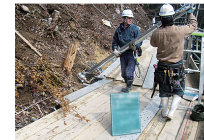
落石防護柵支柱建込
