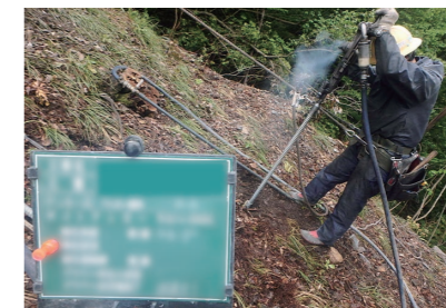
アンカー工（人力削孔）
