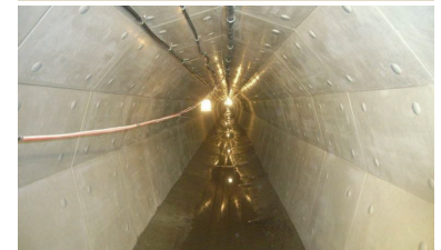
導水路トンネル補修
