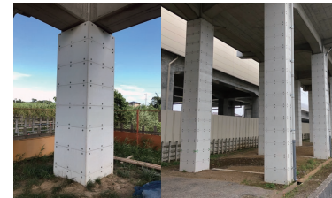
高架橋柱部材の耐震補強
