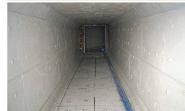
下水処理施設補修
