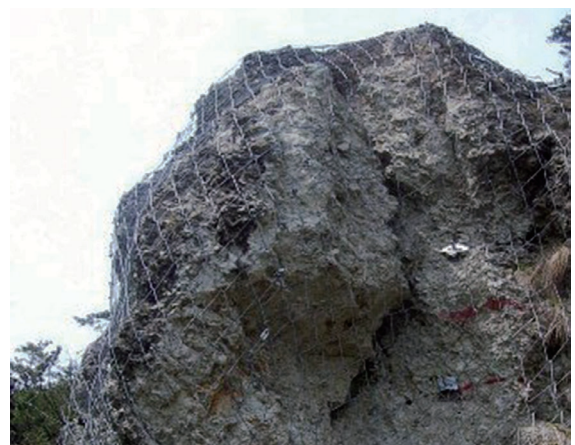
施工事例 (パワーネット (落石予防))
