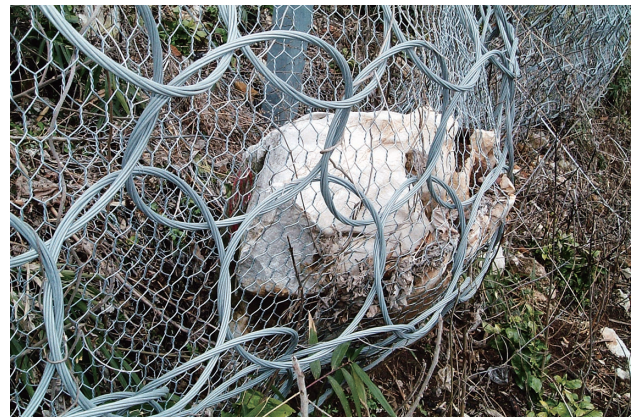
2010年 山口県（1000kJタイプ） 土砂堆積高さ：50m 落石形状：1.9×1.0×0.8m 推定落石エネルギー：530kJ
