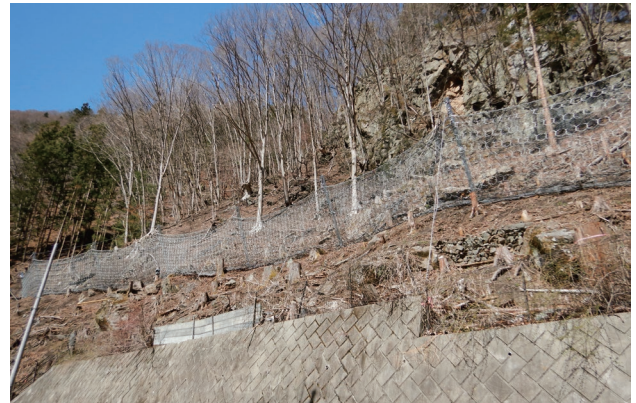
発注者：群馬県藤岡土木事務所 工事件名：補助公共 社会資本総合整備（防災・安全）（防災）（3ヵ年緊急対策） 落石防護柵設置工事 一般県道 上野小海線 多野郡 上野村大字楢原地内楢原工区 施工箇所：群馬県多野郡上野村大字楢原 施工延長：70m
