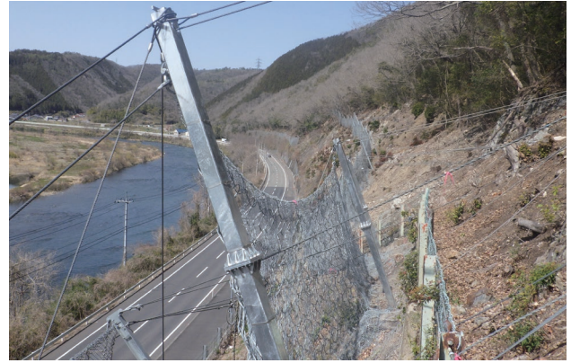
発注者：岡山県美作県民局建設部 工事件名：公共道路工事（法面工その1～5（2019年度）、その1～3（2020年度）） 施工箇所：岡山県久米郡美咲町吉ヶ原 施工延長：227m
