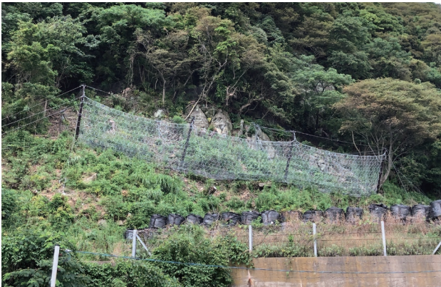
発注者：福井県丹南土木事務所 工事件名：一般国道305号 道路防災対策工事 31-1工事 施工箇所：福井県丹生郡越前町玉川 施工延長：30m
