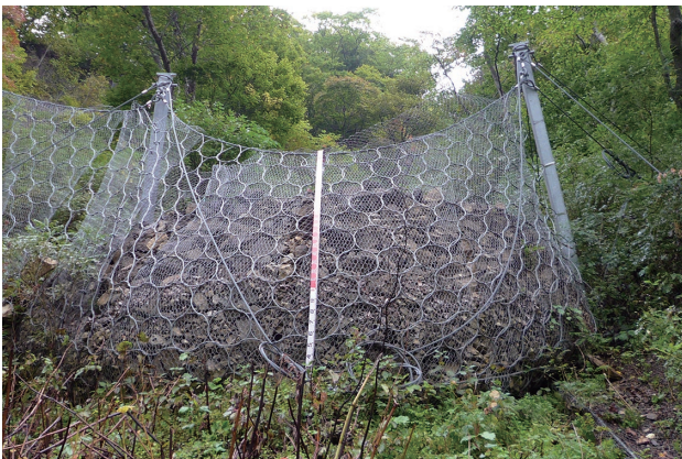
2012年 北海道（250kJタイプ） 土砂堆積高さ：2.3m 土砂推定堆積量：60m 3
