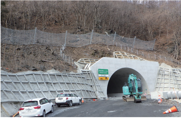
発注者：国土交通省東北地方整備局三陸国道事務所 工事件名：茂市地区道路改良工事 施工箇所：岩手県宮古市茂市 施工延長：120m
