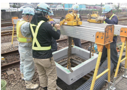
狭隘な用地内での施工
