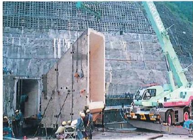
写真：近畿地方地建局 大滝ダム建設工事の状況
