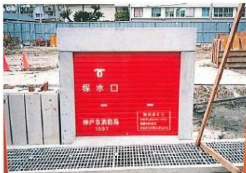
据付け完了状況
