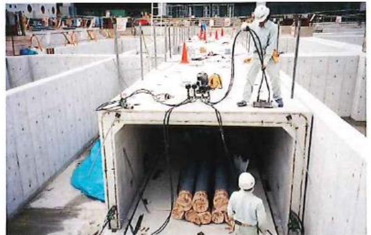
写真: 大阪市中央卸売市場共同溝 施工規模 120ブロック
