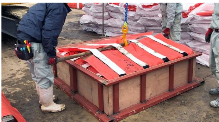
3. 重機やクレーンで吊上げ敷設箇所へ設置
