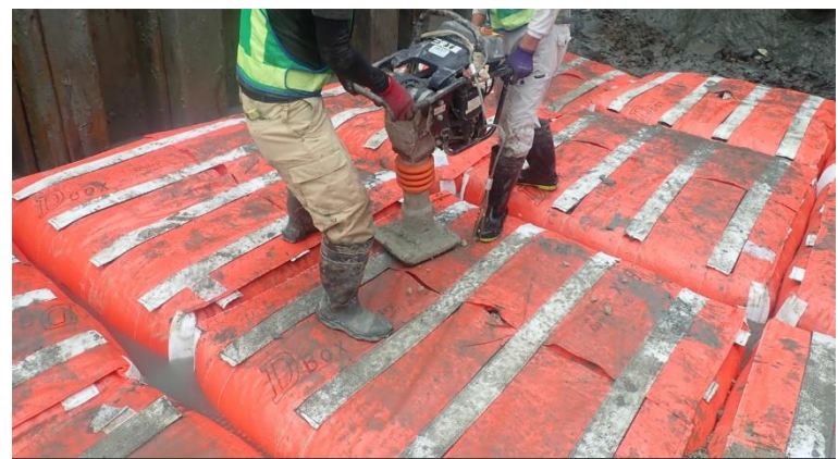
4. 敷設が完了後ランマーで転圧する
