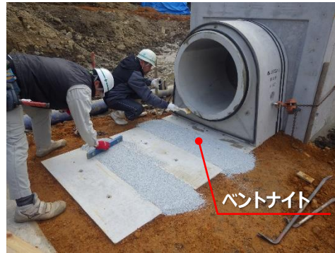
PC基礎版同士の隙間にはベントナ イトを敷設。水みちを作りません！
