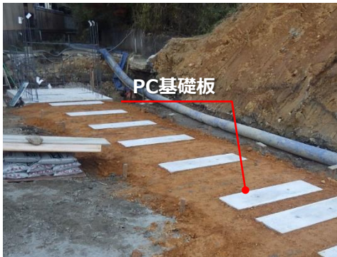
継ぎ目部分にPC基礎版を置くだけ 養生がいりません！
