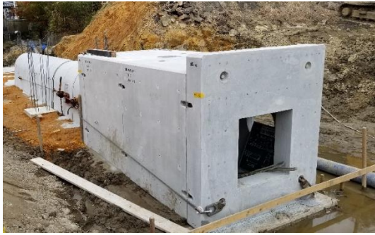
施工に時間のかかる取水部をPC化！
