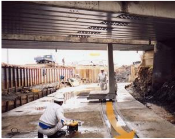
レールスライド施工の概要（イメージ）
