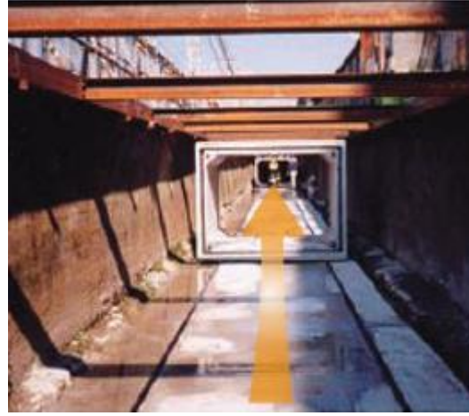
レールスライド施工の概要（イメージ）
