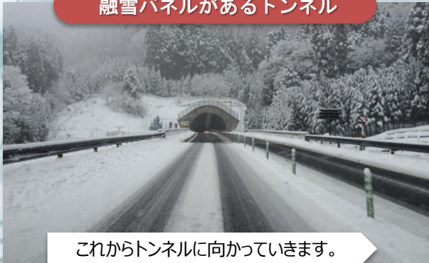
融雪パネルがあるトンネル
