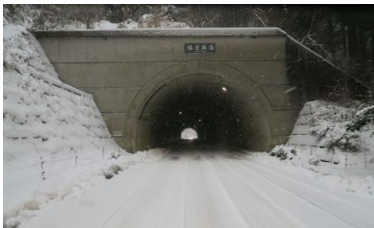
融雪パネルがないトンネル
