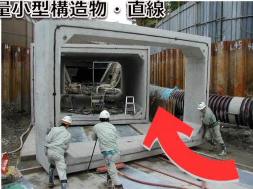
ホバークラフトの原理で重いコンクリート部材を浮かして移動させます。
