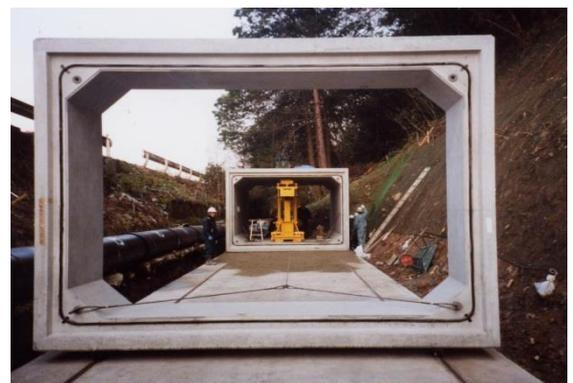
基礎にレールを設置しその上に台車及び函体に乗せ移動させます。
