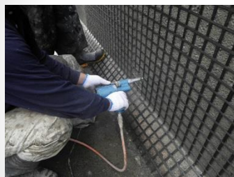
FRP格子筋配置
