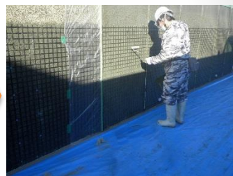
プライマー塗布
