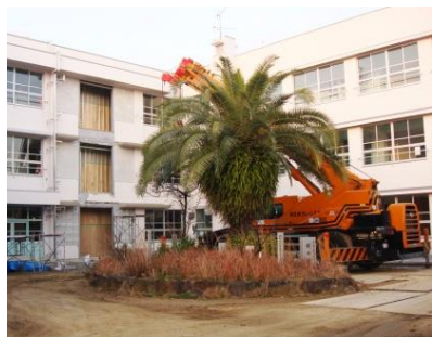
AM7:00 登校時間前に大型重機の配置完了。
