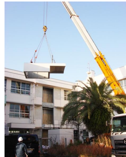
AM8:25 最初の踊り場付部材の据付。
