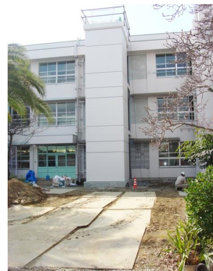
AM12:00 セット完了。 午前中で重機は帰りました!!
