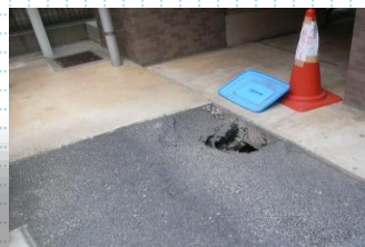
外側の陥没状況
