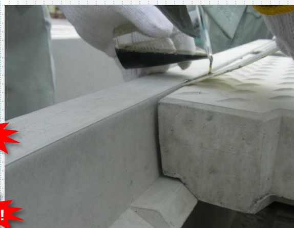
樹脂注入状況
