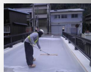
ドーロガード(JC-02)打設(t=15mm)
