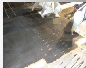
ドーロガード(J-02)打設
