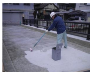
プライマー塗布
