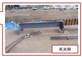
特殊な形状の製品でも、製品形状に応じた吊 り上げ・吊り降ろし方法により、安全に据付を 行えます。本現場では、専用の吊天秤で施工 を行いました。
