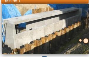
プレキャスト部材据付完了です。 この後、現場打ちコンクリートで地覆や角落し 部分を構築致しました。
